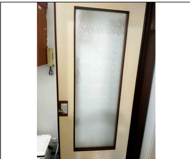
Foto 17: Particolare porta interna
