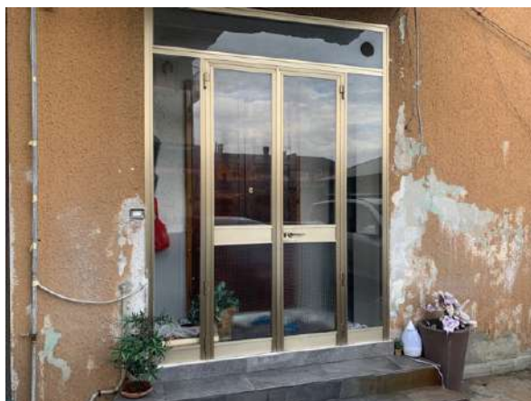
Veranda ingresso – p.t.
