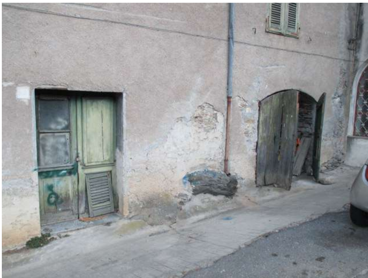
BDA foglio 10 particella 154 subalterno 2 - vista esterna
