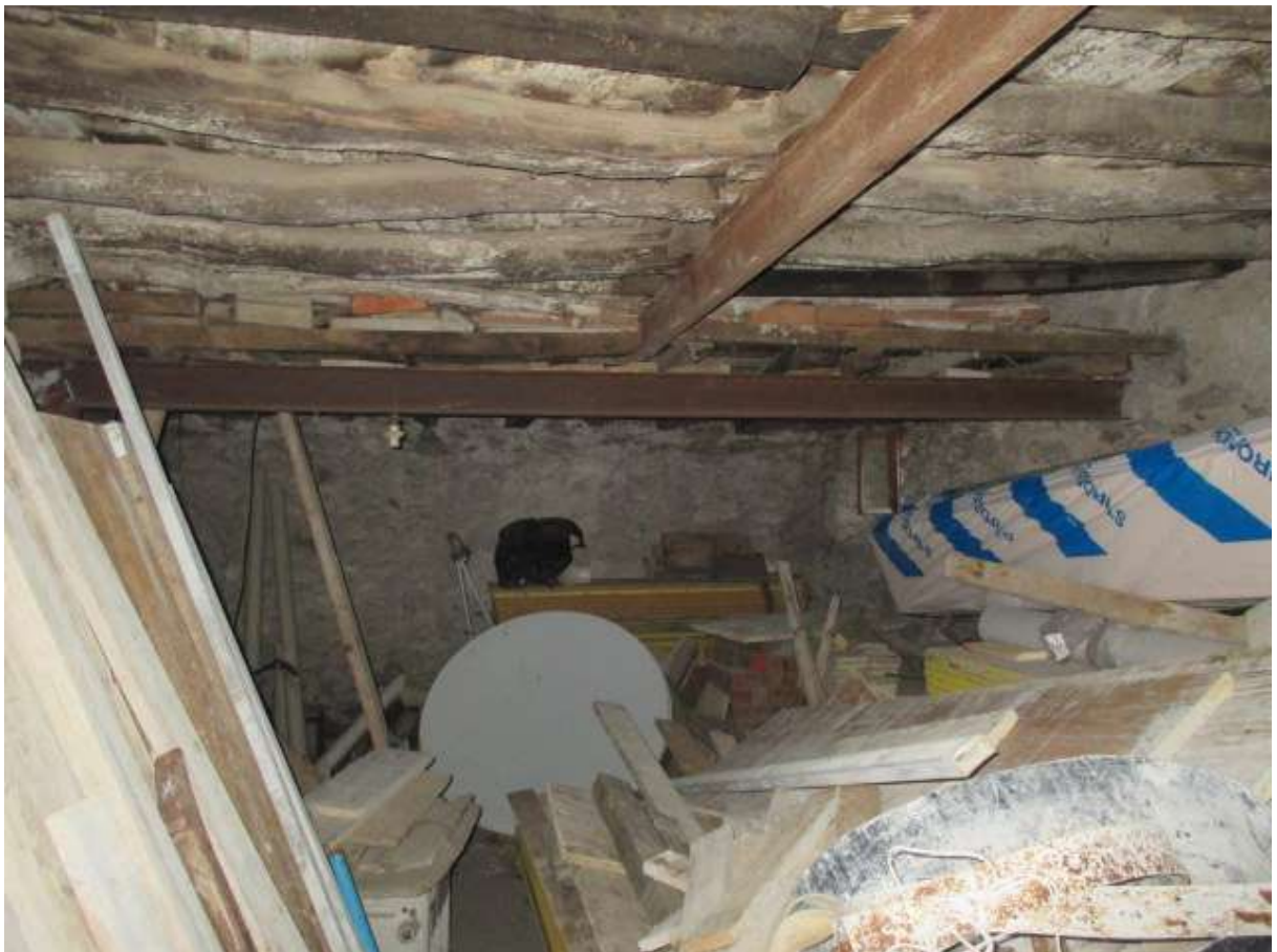
BDA foglio 10 particella 154 subalterno 2 - vista interna
