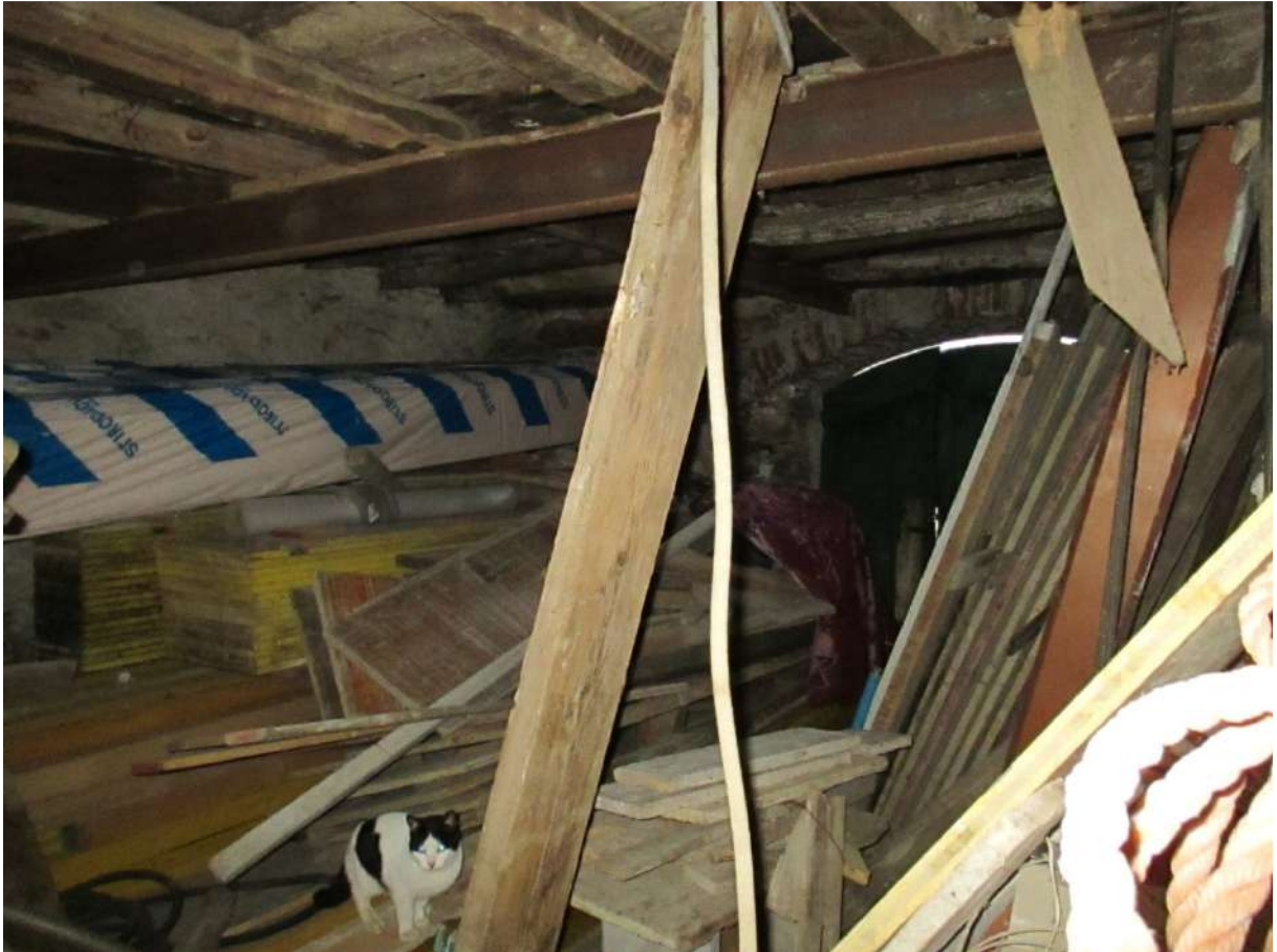
BDA foglio 10 particella 154 subalterno 2 - vista interna
