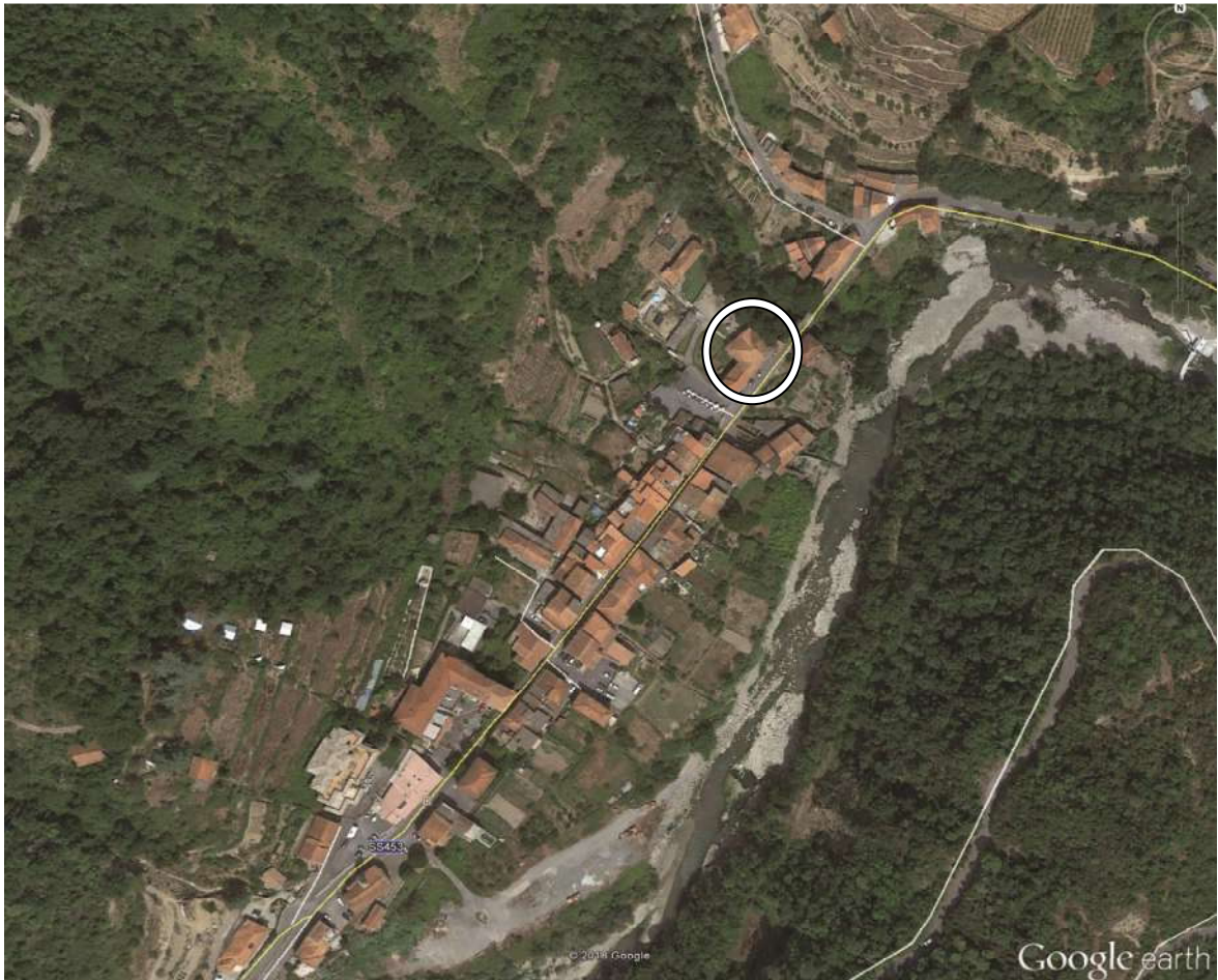
vista aerea per inquadramento di insieme
