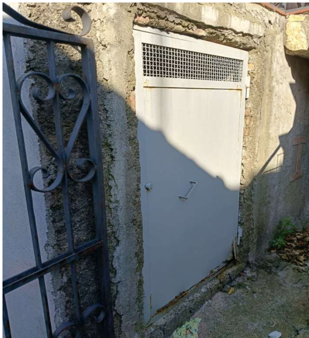
- Ingresso ad uno dei locali accessori posti al piano seminterrato
