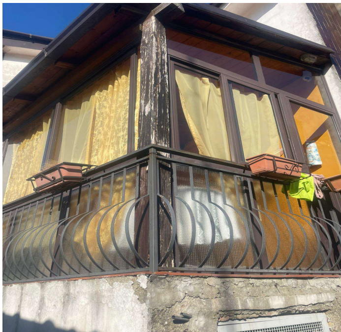
- Particolare della veranda chiusa al piano terra
