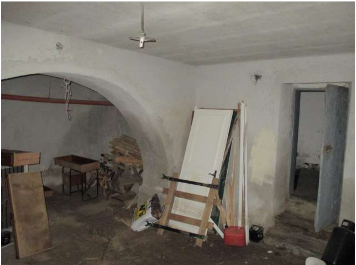
BDA foglio 10 particella 154 subalterno 1 - vista interna
