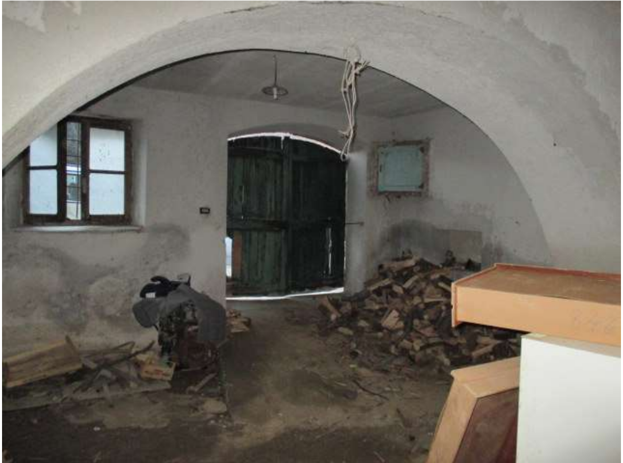
BDA foglio 10 particella 154 subalterno 1 - vista interna
