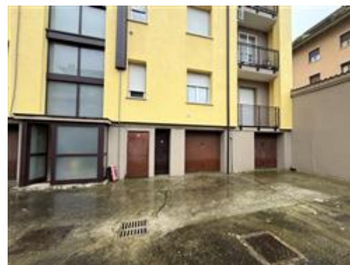
Accesso a locale cantina (seconda porta a sinistra del vano scala)
