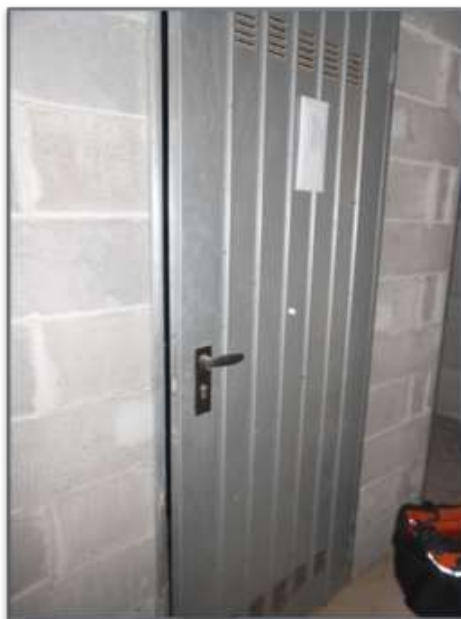
Foto 1 porta ingresso al magazzino/cantina
