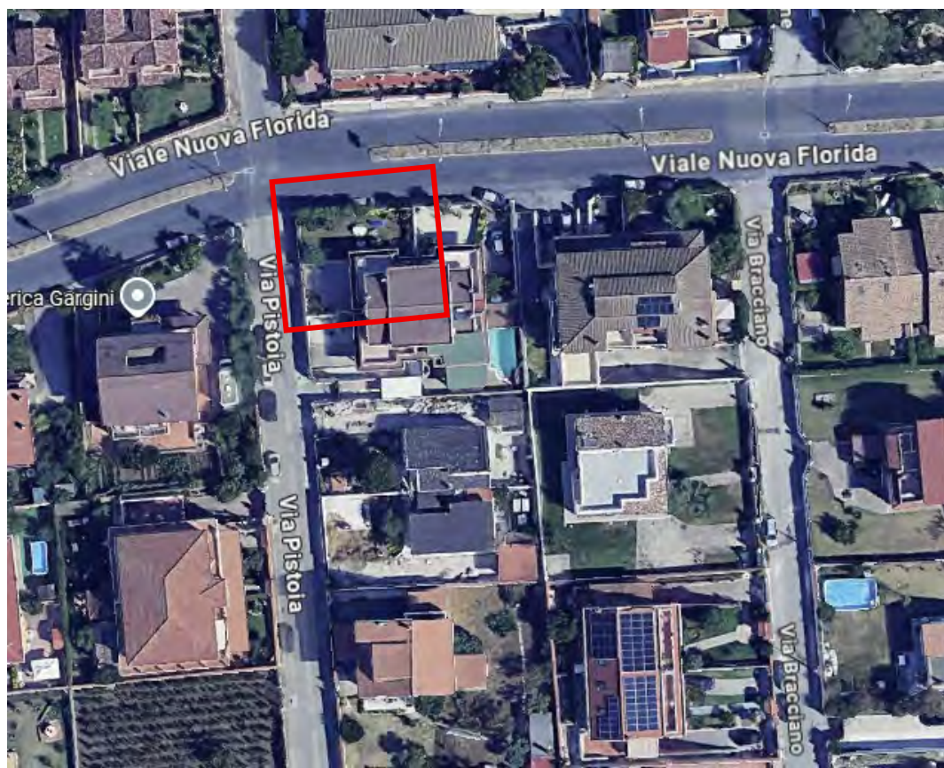
Particolare vista dall'alto fabbricato
