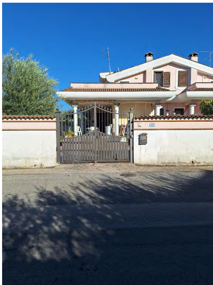
FOTO N. 2: Particolare cancello su Via Pistoia
