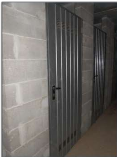
Foto 13 ingresso alla cantina
