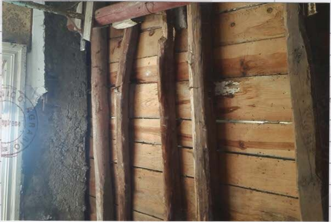
Posa in opera del tavolato sul muro perimetrale
