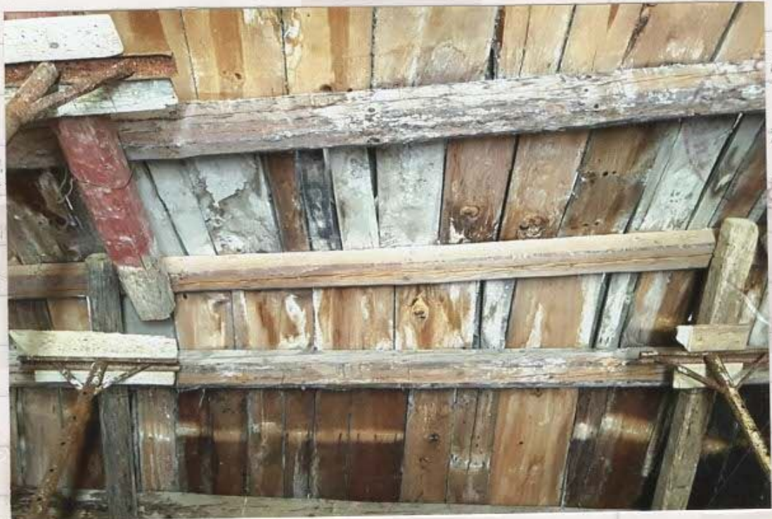
travi in legno sostituite
