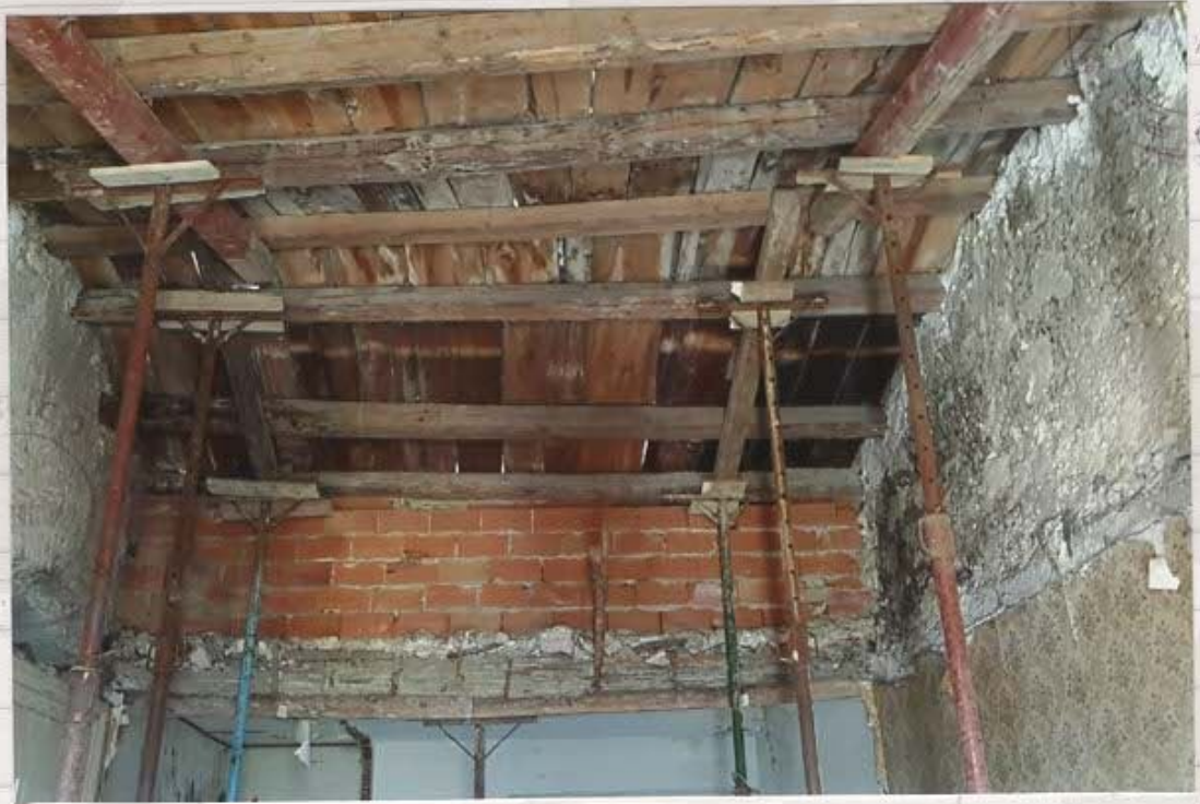
Sostituzione delle travi in legno ed ancoraggio con travi in ferro
