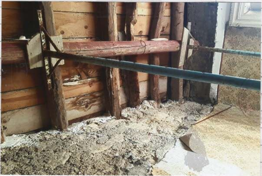
Posa in opera dei sostegni in ferro a perdere
