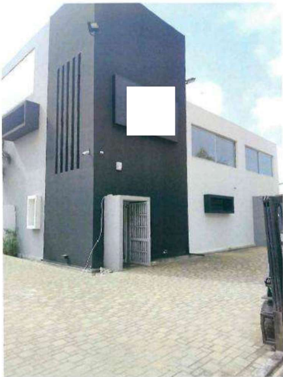
FOTO INGRESSO SCALA – UFFICI PIANO PRIMO SUB 29
