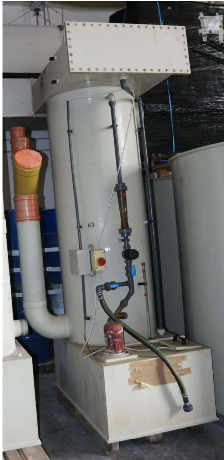
Dettaglio Torre lavaggio fumi acidi – non attiva
