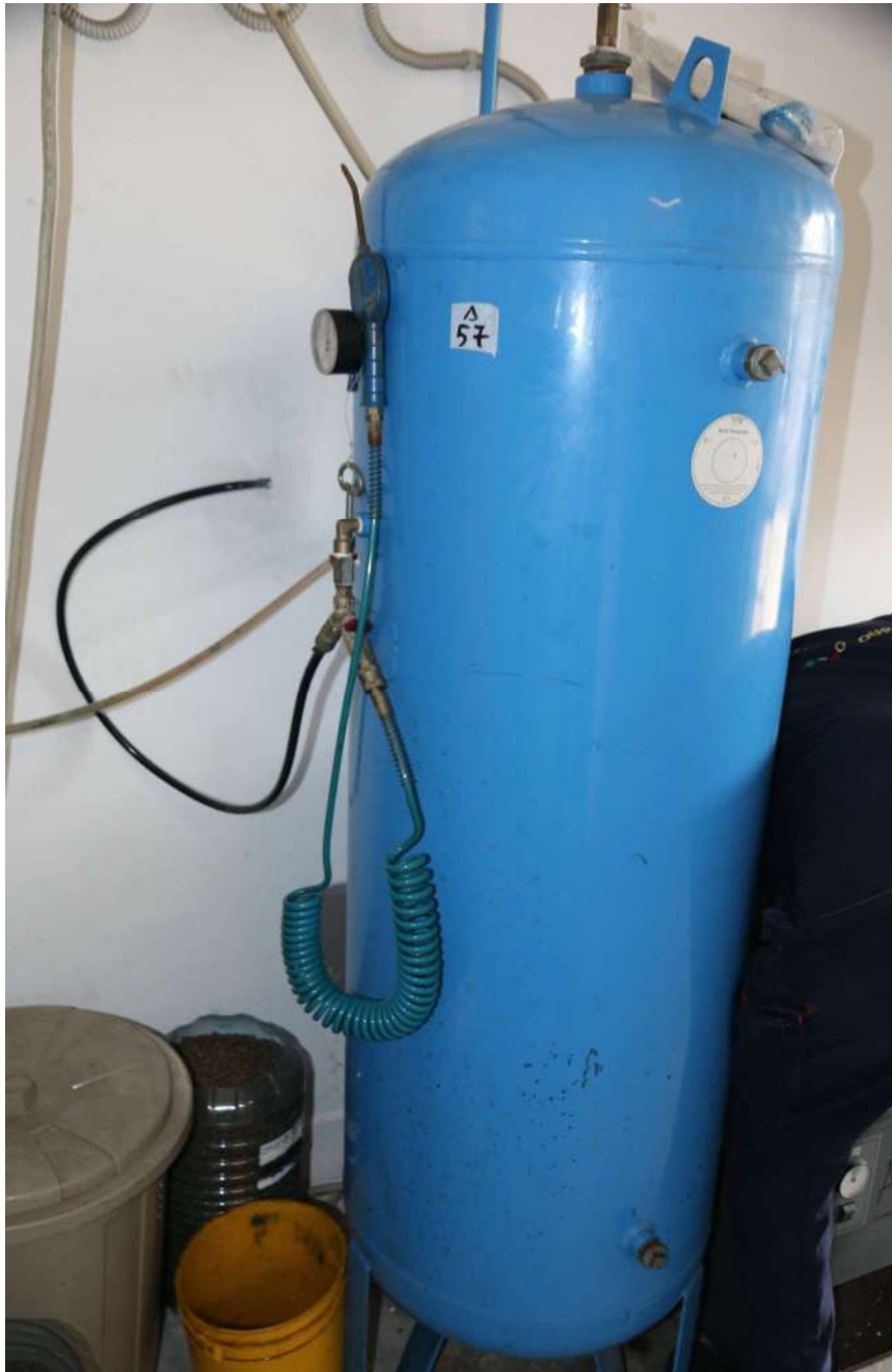
Complesso del serbatoio SICC – di circa lt.270
