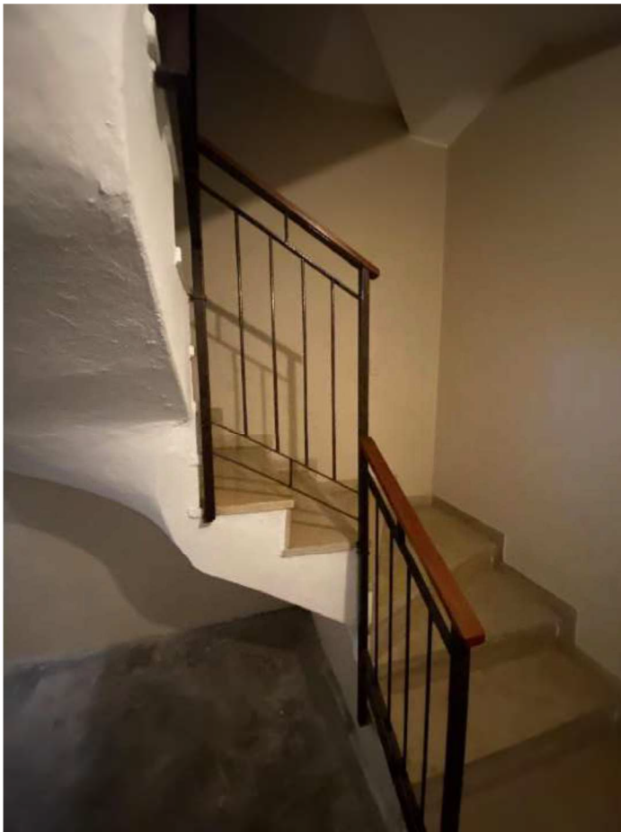
Scala di accesso alle cantine
