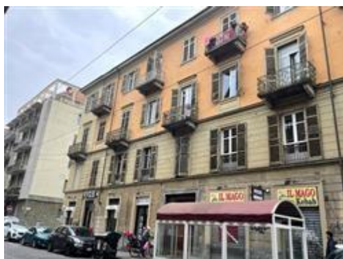
Condominio via Napione, 27
