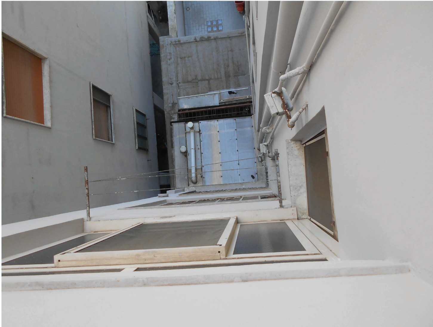
Foto n 13: Appartamento al 5° piano-affaccio disimpegno zona giorno
