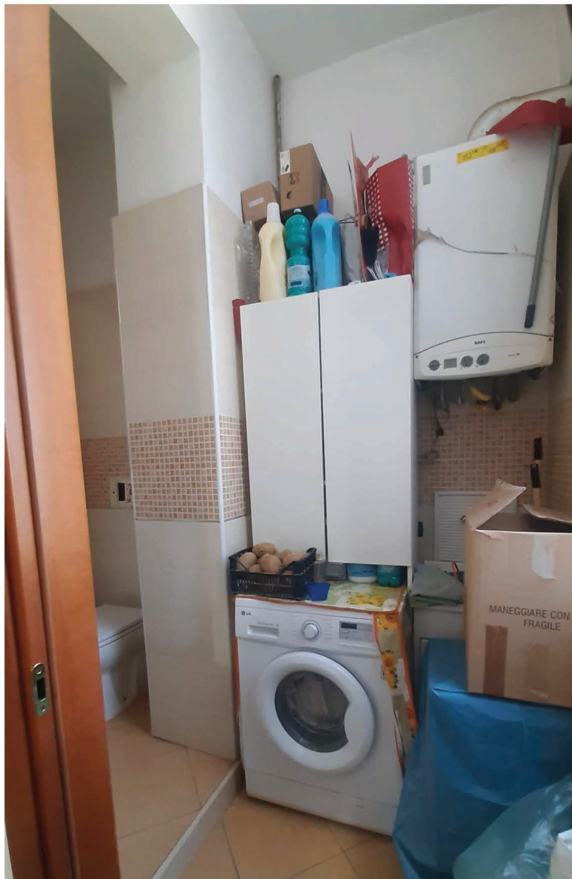
Foto n.16: Appartamento al 5° piano- servizio igienico a3
