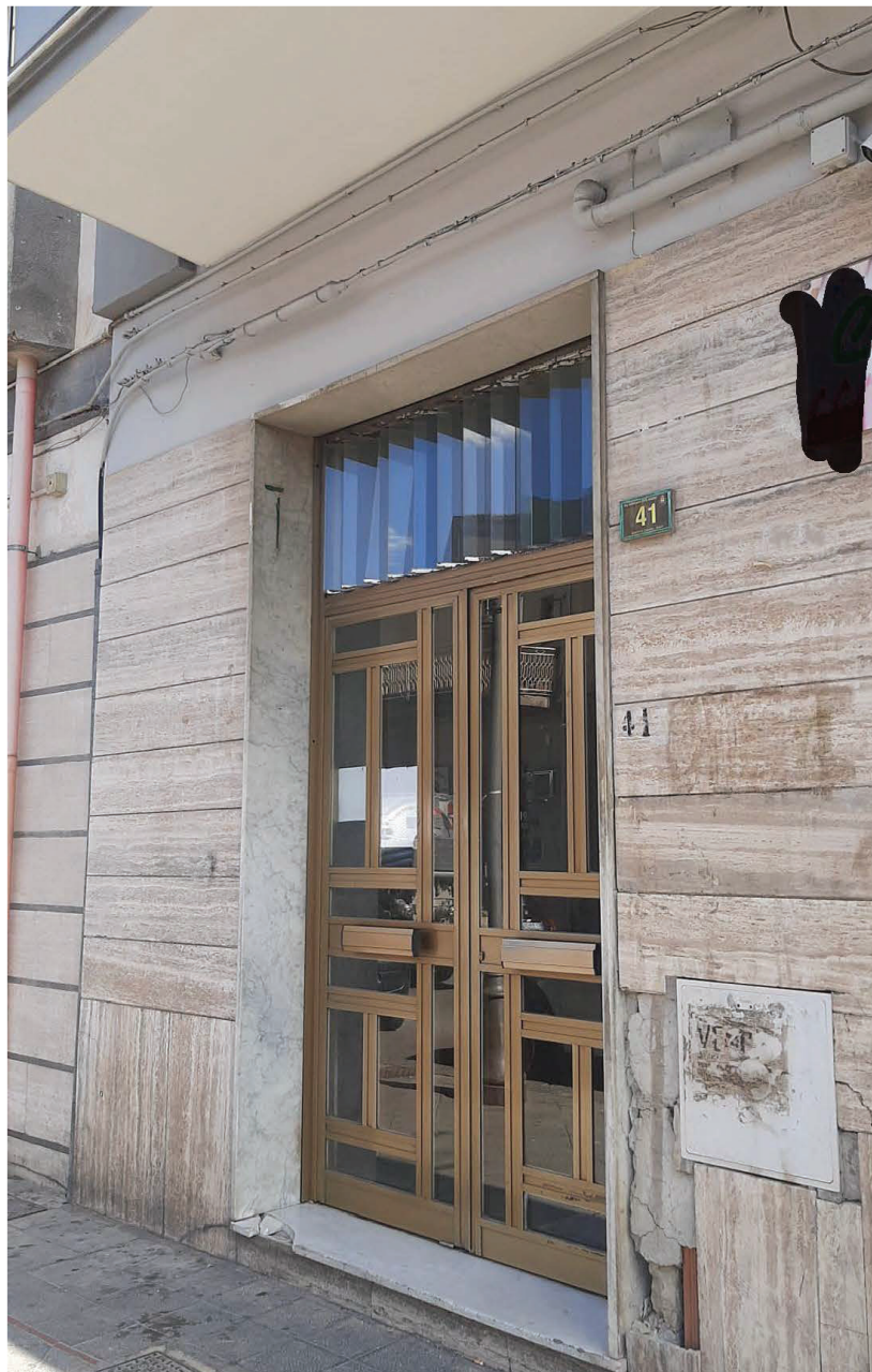
Foto n. 2: Accesso dal civico 41 di Via Gennaro Orlando
