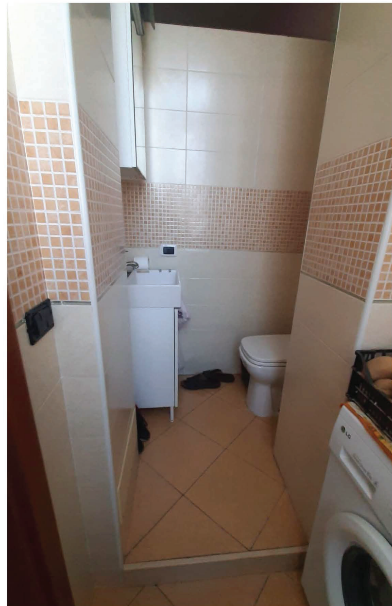
Foto n 17: Appartamento al 5° piano- servizio igienico a3 -
