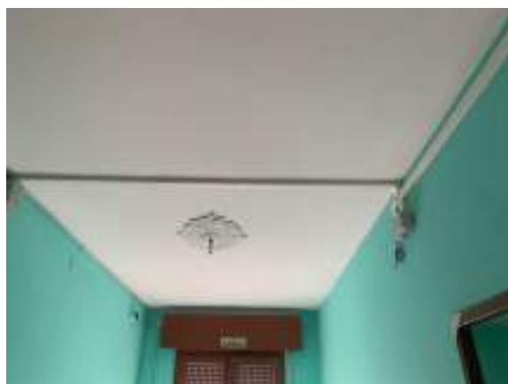
vista 2 soggiorno (soffitto)
