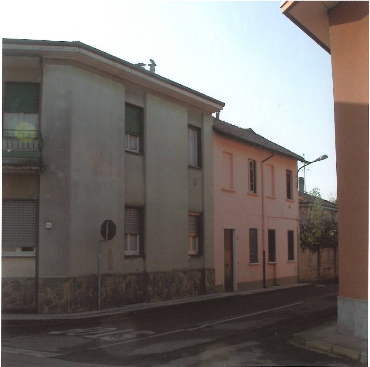
Foto n°12: Via XXV Maggio n°45 - Prospetti su Via Torquato Tasso dei fabbricati di cui ai mappali 169 (grigio) e 60 (rosa).
