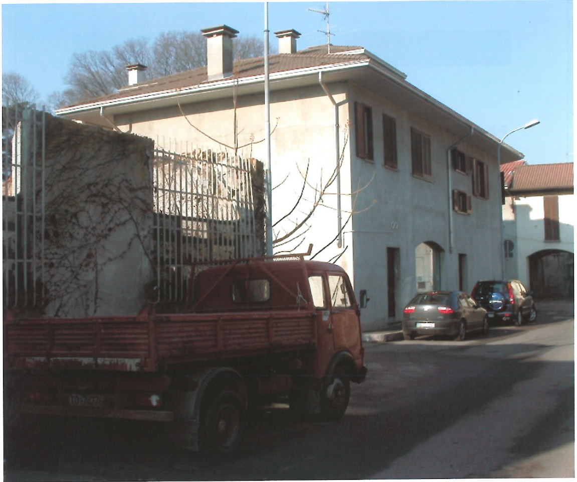
Foto n°3: Via Mazzini n°2 - Il prospetto su Via Mazzini
