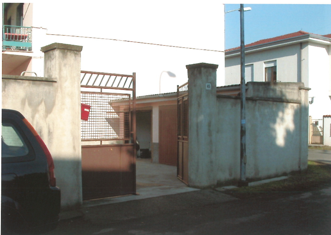
Foto n°7: Via XXV Maggio n°45 - L'ingresso carraio al cortile sulla destra i box e ripostiglio di cui al mappale 220.
