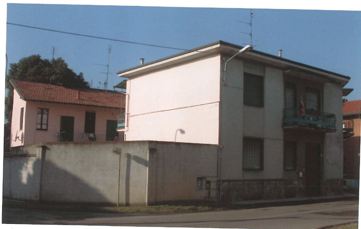
Foto n°10: Via XXV Maggio n°45 - Prospetto su Via S. Francesco dell'edificio di cui al mappale 169,
