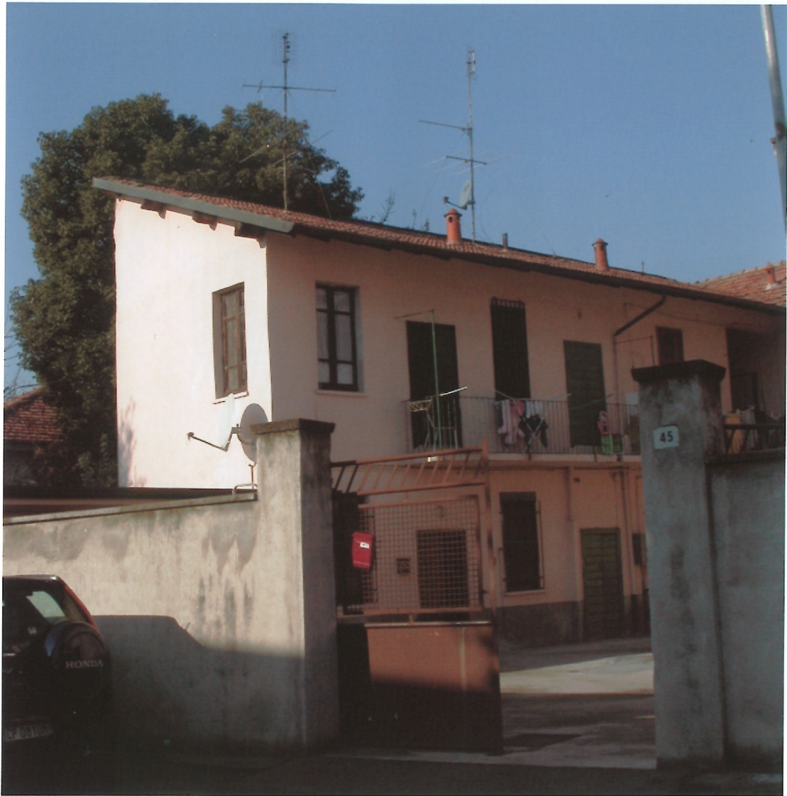
Foto n°8: Via XXV Maggio n°45 - Parte del fabbricato di cui al mappale 60.
