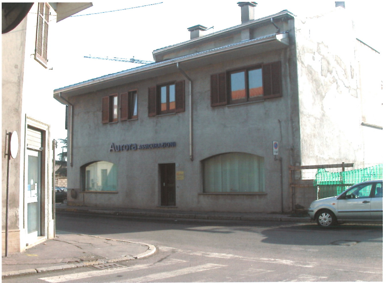
Foto n°2: Via Mazzini n°2 - Il prospetto sulla Via Cadorna
