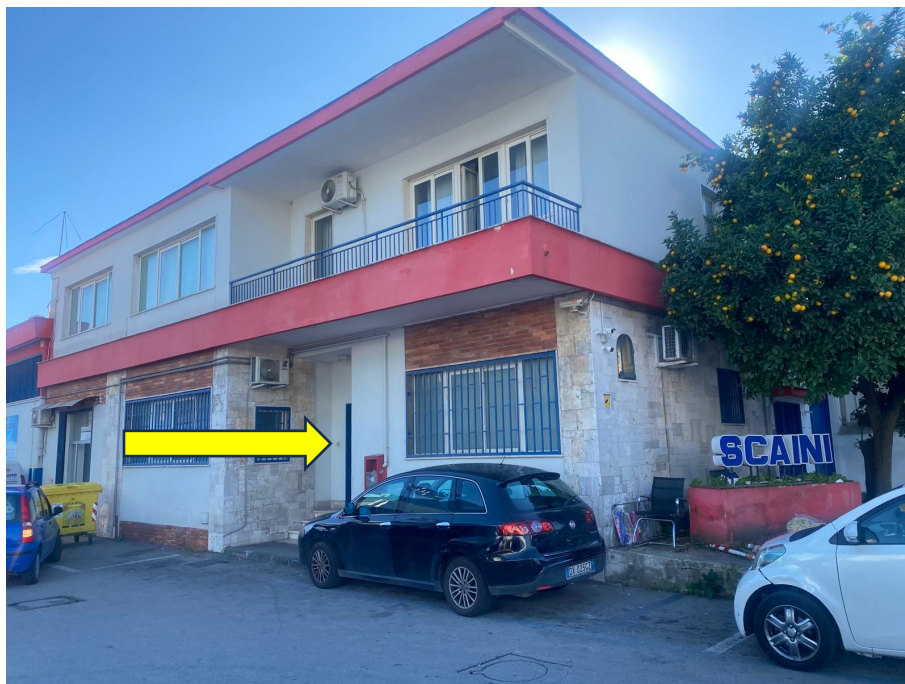
Particolare del fronte del fabbricato si individua l'accesso all'immobile staggito Sub 15
