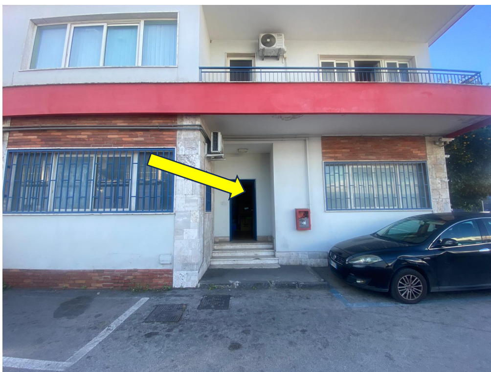
Particolare del fronte del fabbricato si individua l'accesso all'immobile staggito
