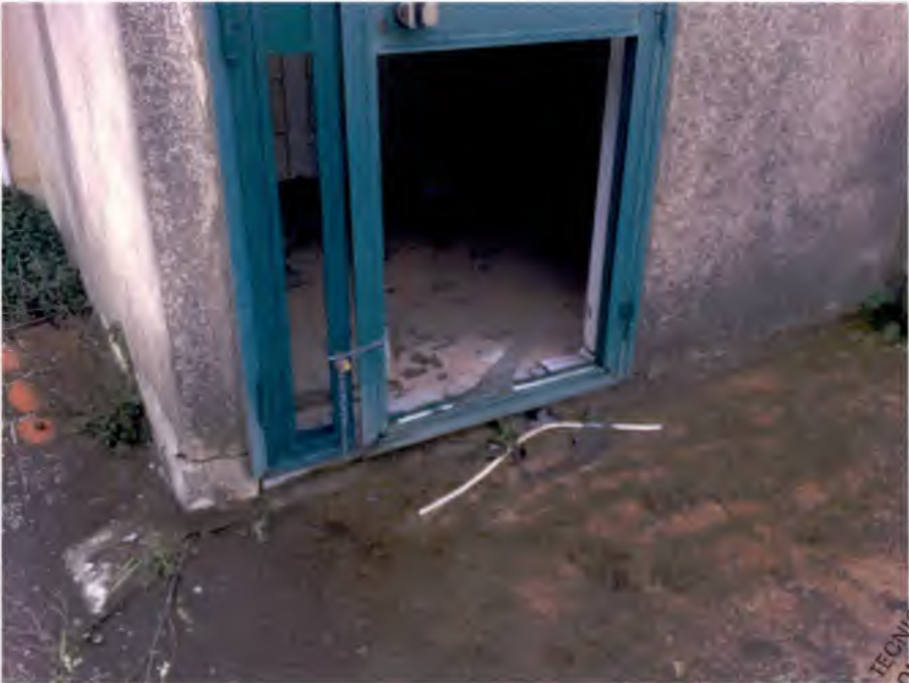
FOTO 5 : Particolare servizio igienico a piano terra.
