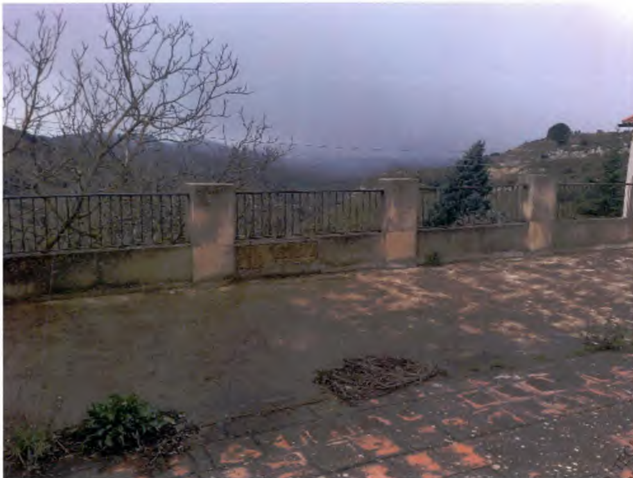
FOTO 2 : Particolare Cortile interno.
