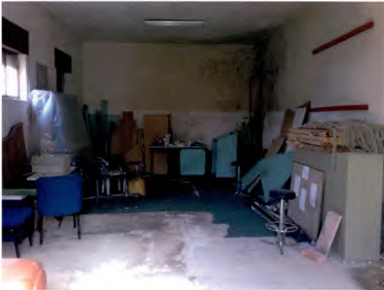
FOTO 18: Particolare vano a piano S2.
