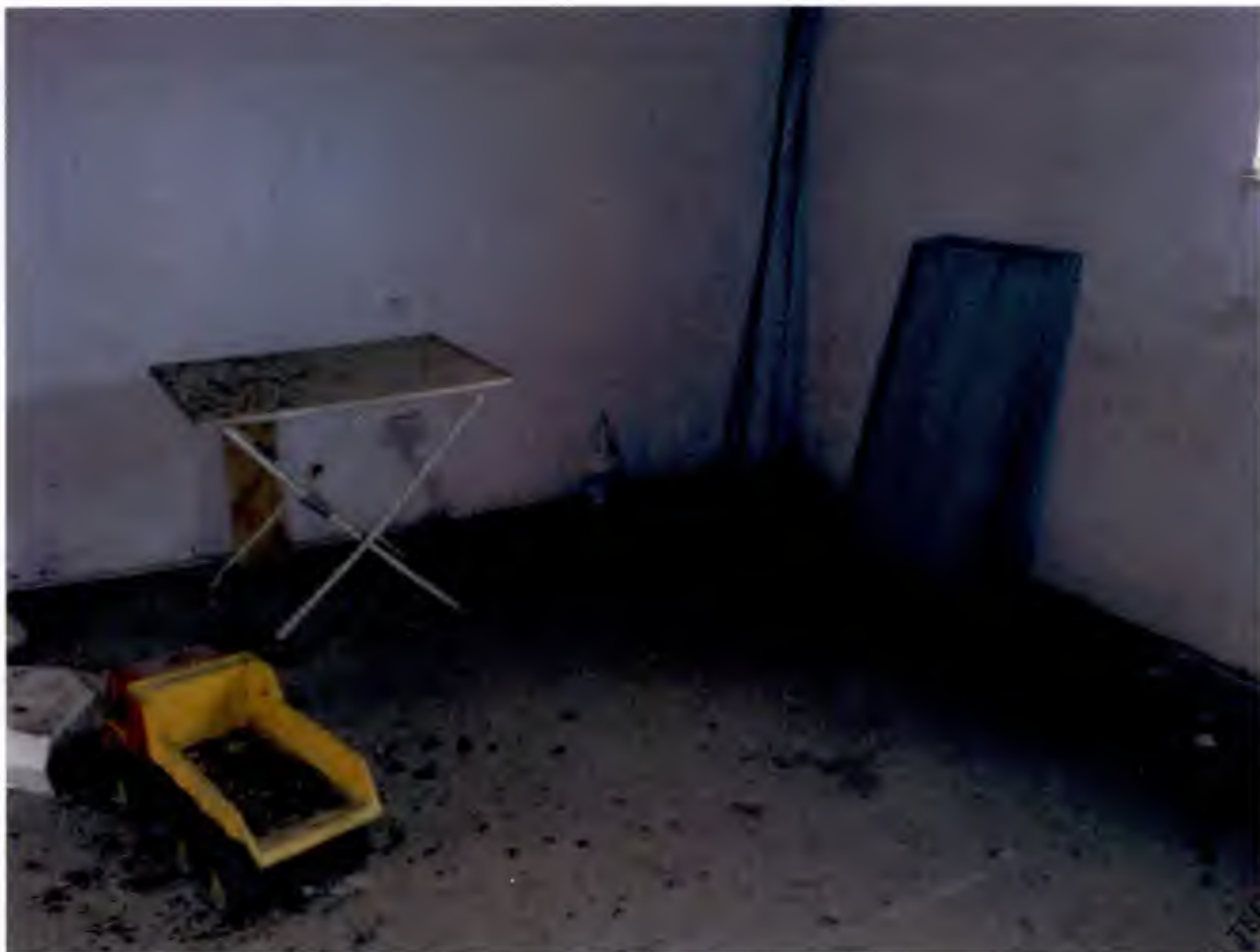
FOTO 13 : Particolare vano piano terra
