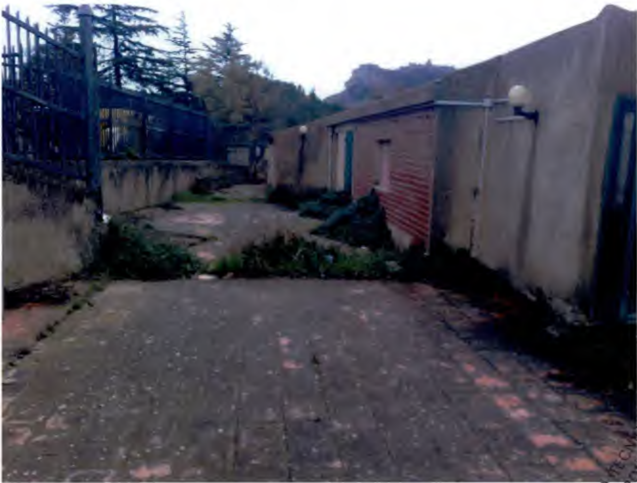
FOTO 3: Particolare Cortile- prospetto piano terra.
