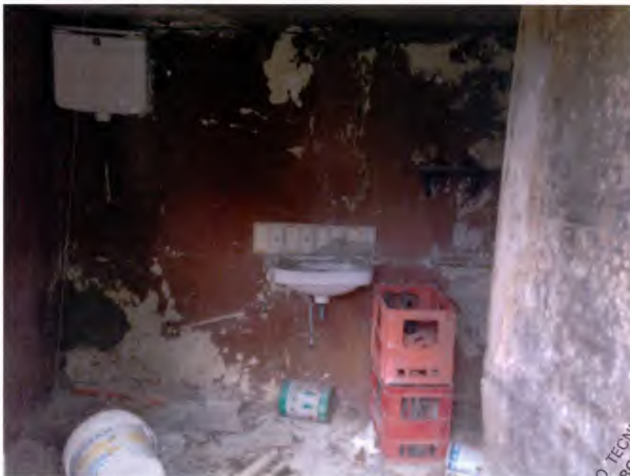
FOTO 8: Particolare servizio igienico piano S1.
