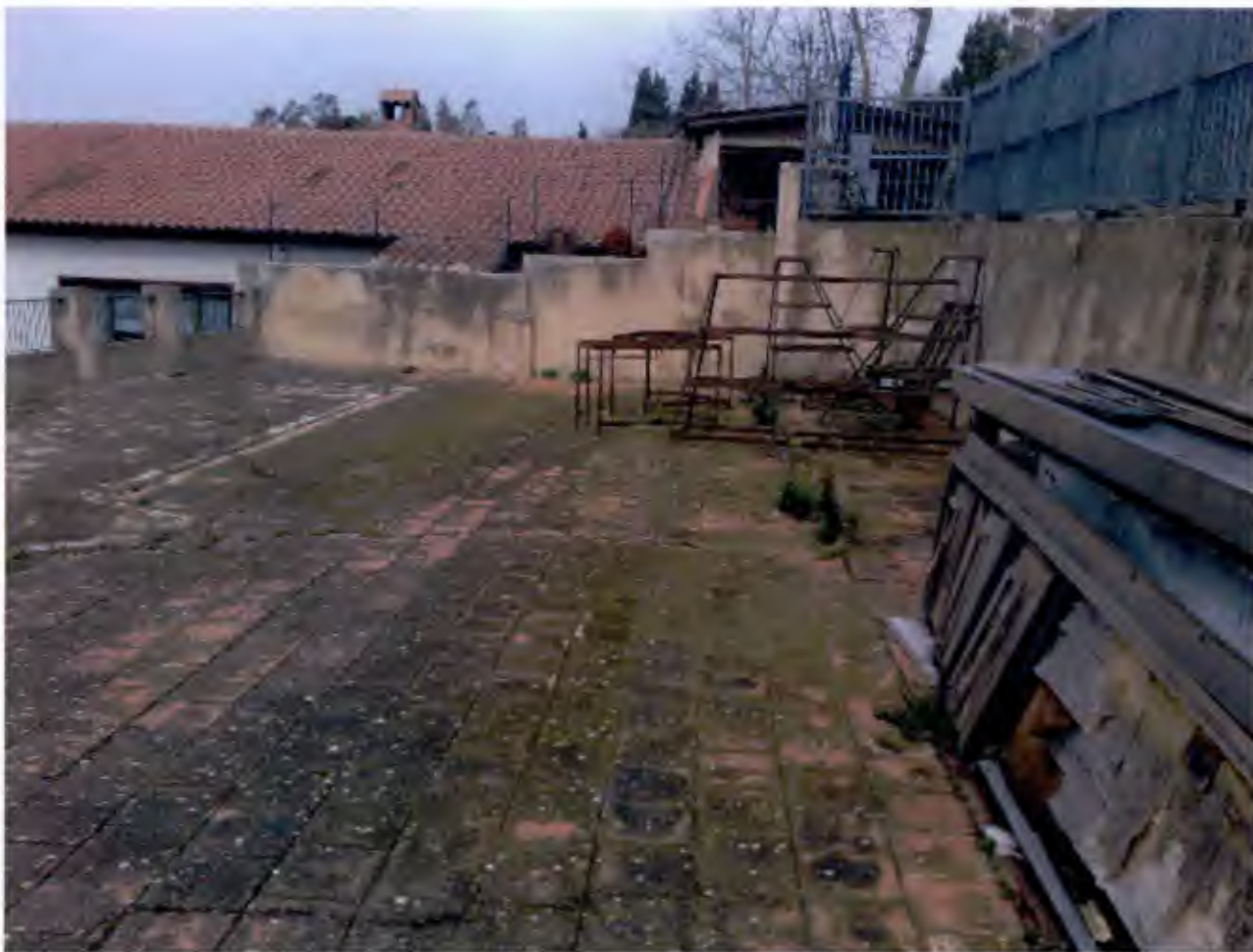
FOTO N. 1 – Particolare Cortile interno.
