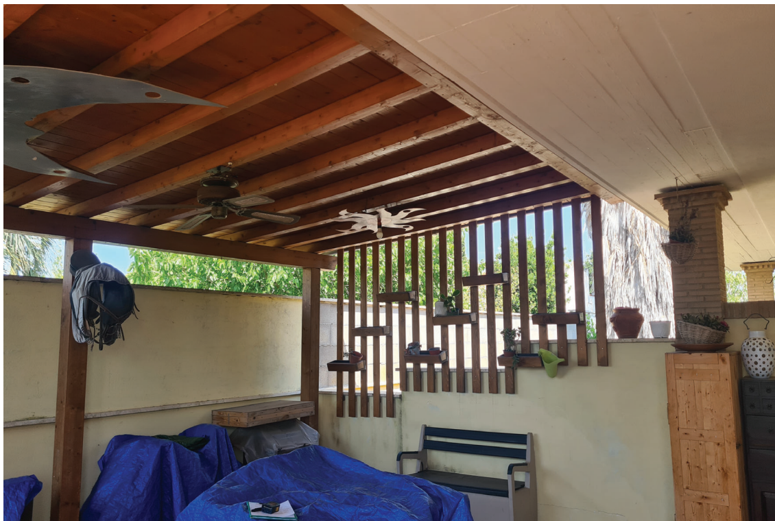
Foto 6- vista tettoia da rimuovere
