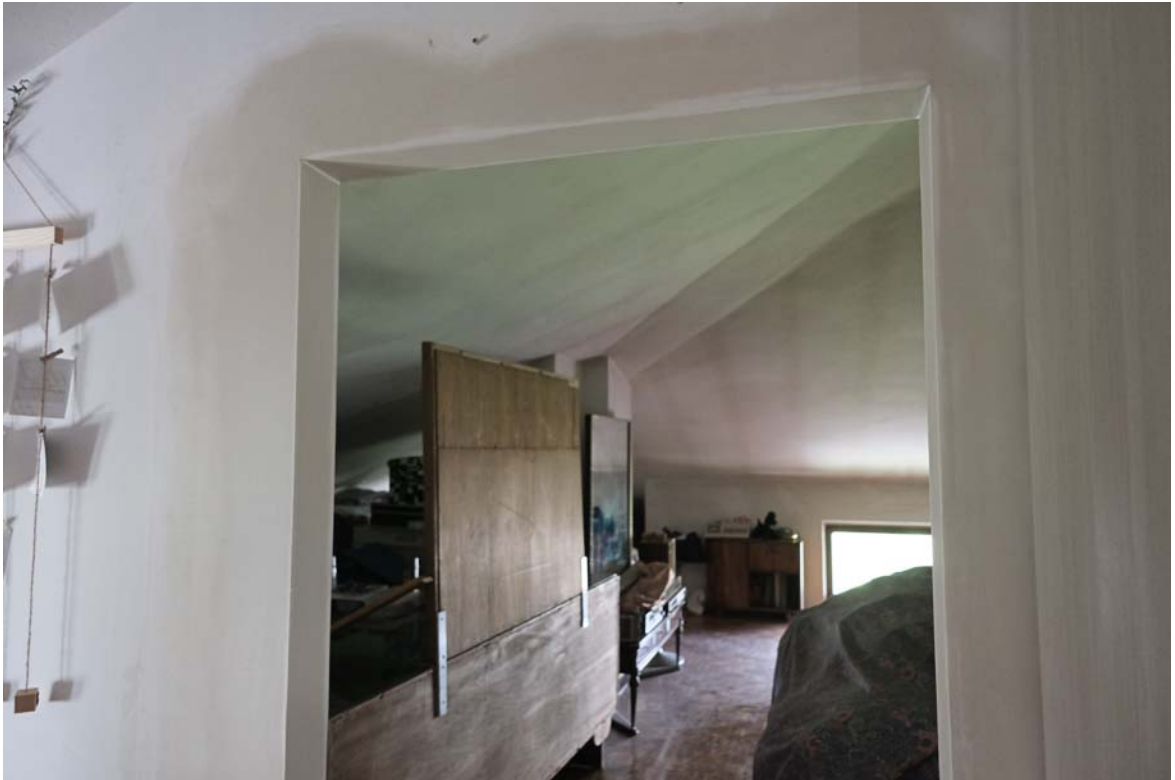
porta piano secondo sottotetto Villa Via Pierpaoli
