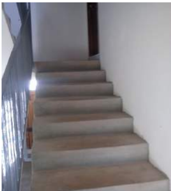
FOTO N. 24 – IMMOBILE N. 3 – 4 – 5 – 6 - FABBRICATO PIAZZA PAPA GIOVANNI XXII – SCALA
