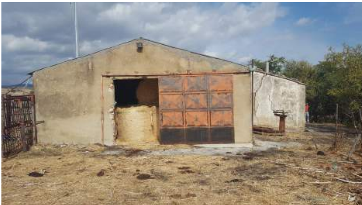
FOTO N. 5 – IMMOBILE N. 1 - FONDO C.DA S.IPPOLITO – FABBRICATO PART. 19
