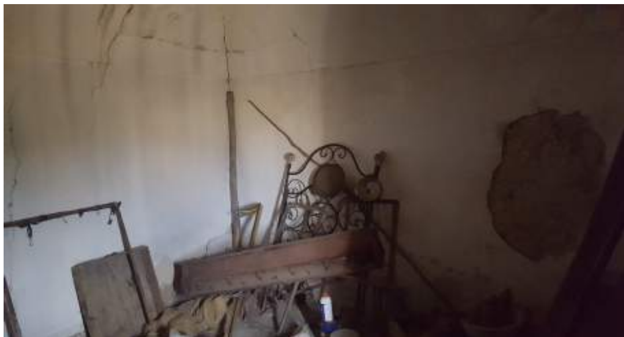
FOTO N. 13 – IMMOBILE N. 1 - FONDO C.DA S.IPPOLITO – FABBRICATO PART. 19 - VANO
