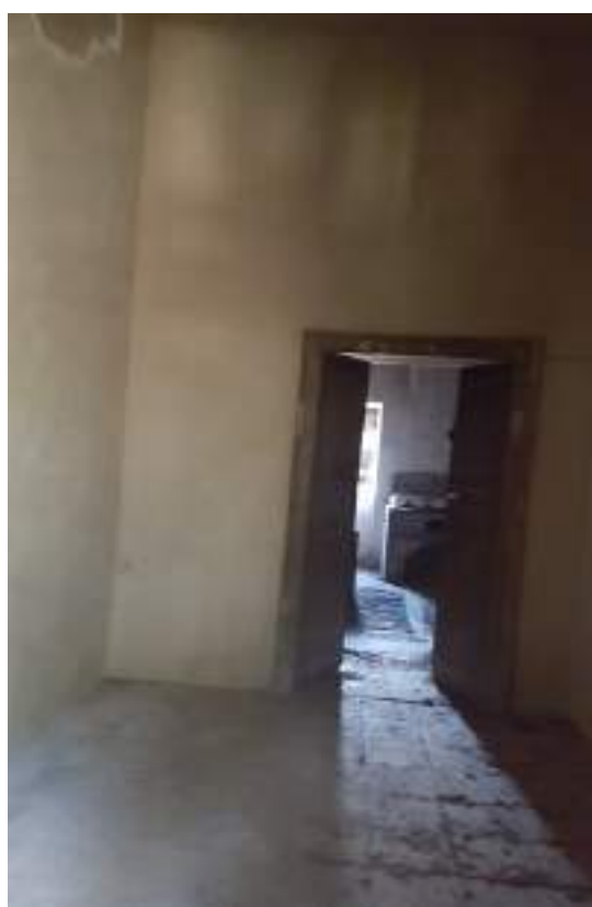
FOTO N. 8 – IMMOBILE N. 1 - FONDO C.DA S.IPPOLITO – FABBRICATO PART. 19 - VANO
