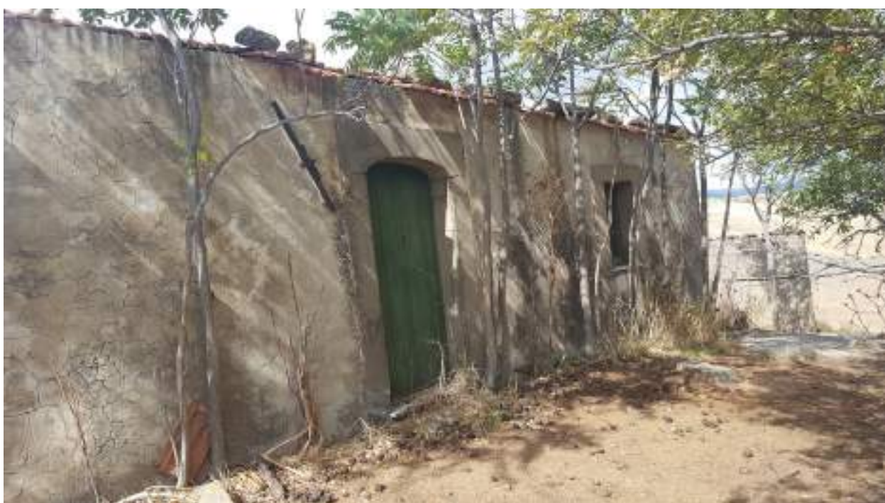
FOTO N. 6 – IMMOBILE N. 1 - FONDO C.DA S.IPPOLITO – FABBRICATO PART. 19
