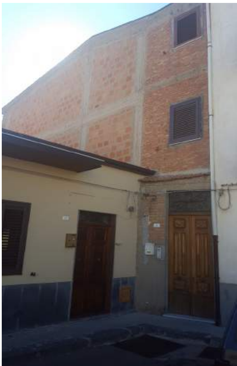
FOTO N. 21 – IMMOBILE N. 3 – 4 – 5 – 6 - FABBRICATO PIAZZA PAPA GIOVANNI XXII – PROSPETTO PRINCIPALE
