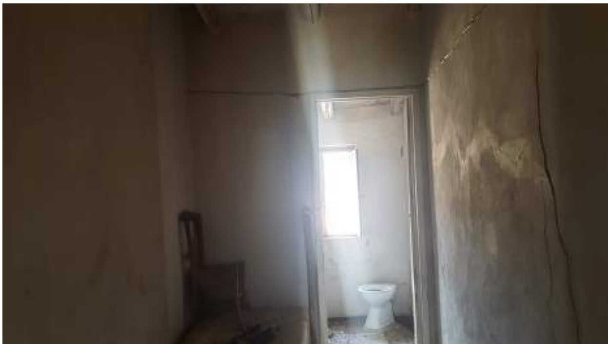
FOTO N. 11 – IMMOBILE N. 1 - FONDO C.DA S.IPPOLITO – FABBRICATO PART. 19 - VANO
