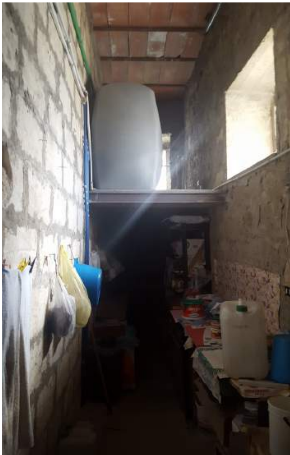
FOTO N. 33 – IMMOBILE N. 3 - FABBRICATO PIAZZA PAPA GIOVANNI XXII RIPOSTIGLIO – P.SEM.2
