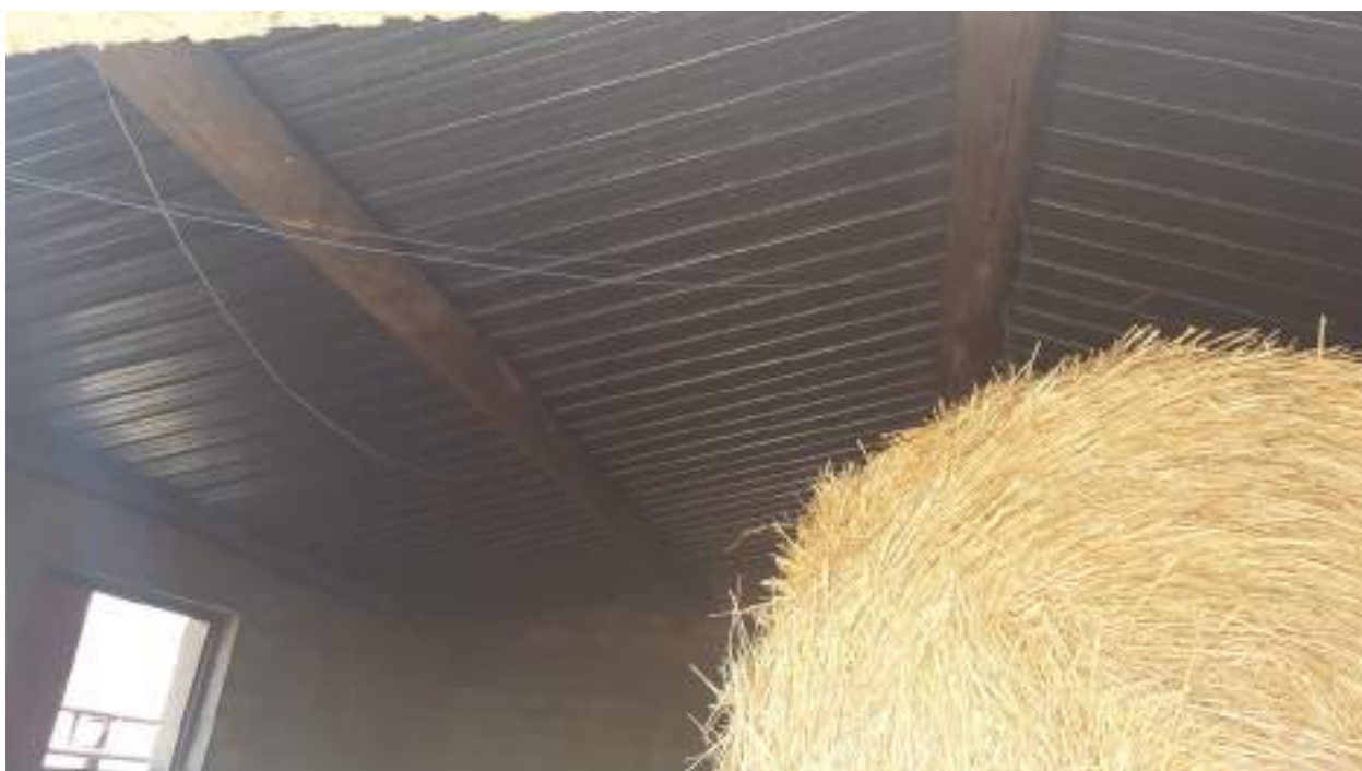
FOTO N. 7 – IMMOBILE N. 1 - FONDO C.DA S.IPPOLITO – FABBRICATO PART. 19 - VANO MAGAZZINO
