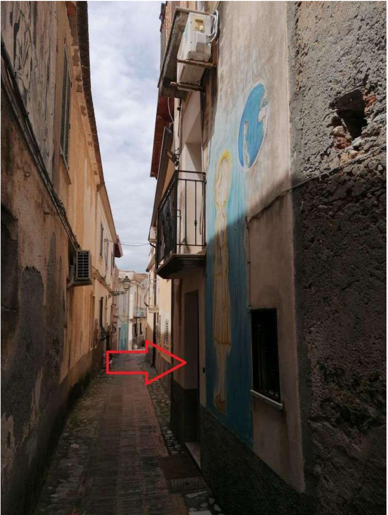
Foto n° 2 – Prospetto Ovest fabbricato interessato con accesso P.T. su Via Calvario (direzione Nord) –
