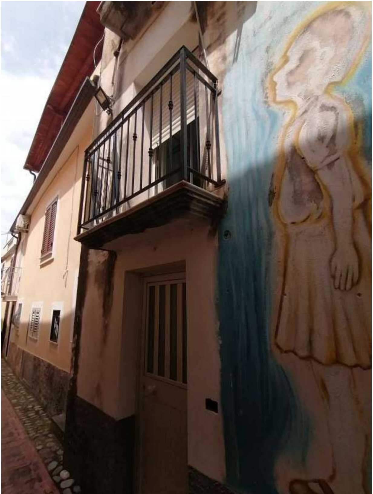
Foto n° 4 – Zoom Prospetto Ovest fabbricato interessato su Via Calvario –
