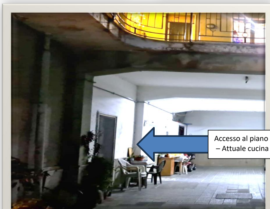
Figura 10: Ingresso interno al fabbricato da cui si accede al LOTTO 1 e LOTTO 2
