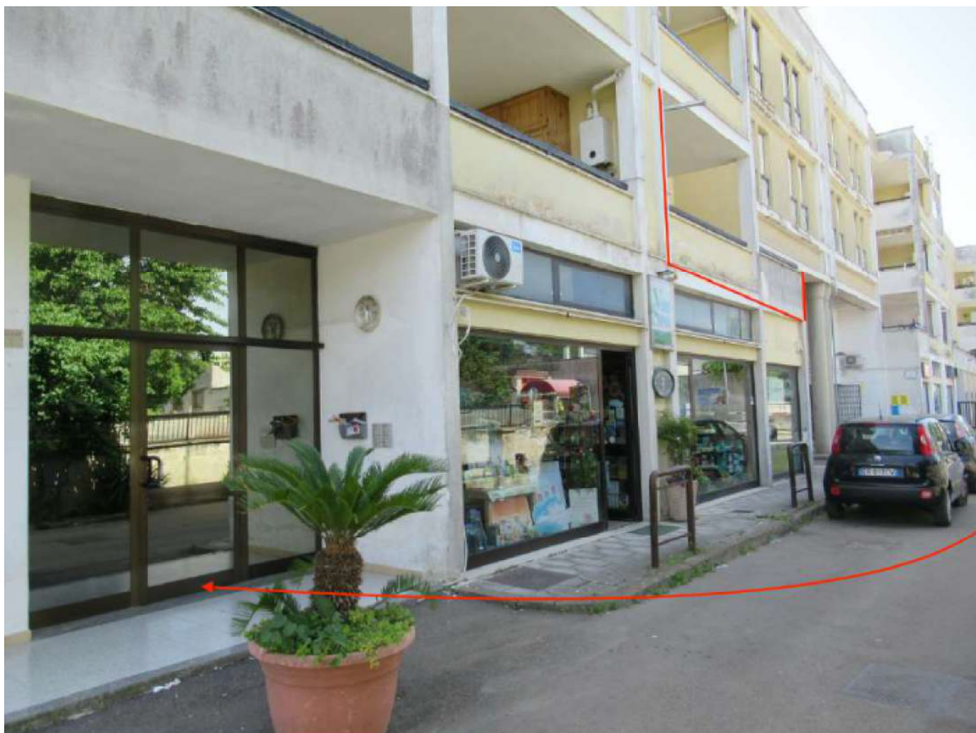
2 - VISTA INGRESSO _ Vano Scala E_
