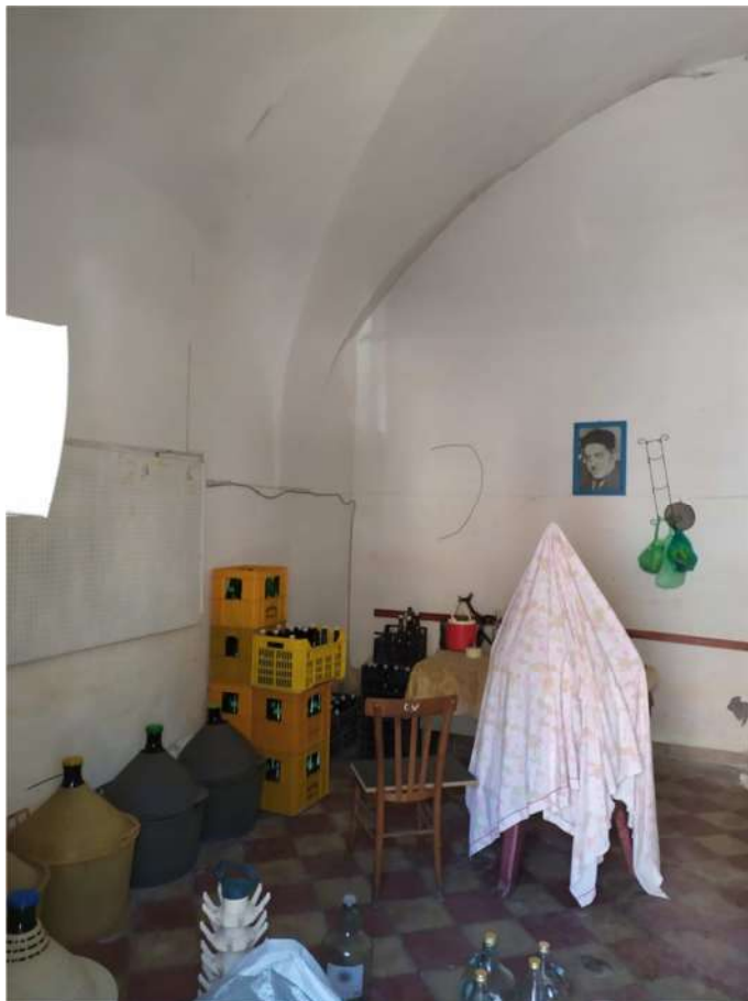
Foto 4 _ Lotto n. 1 _ Particolare pavimentazione e finitura pareti
