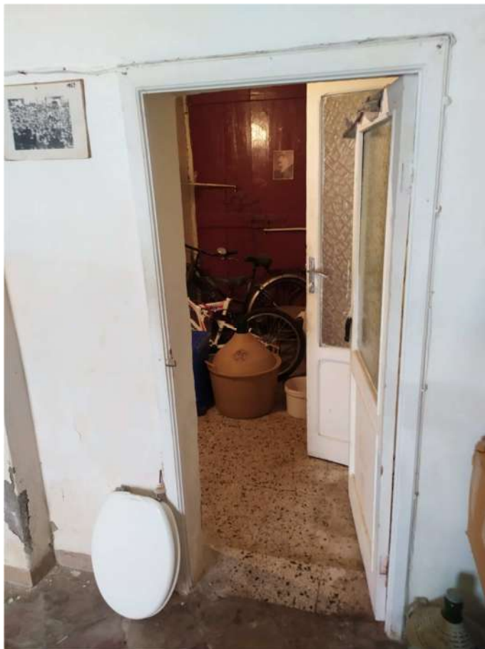
Foto 6 _ Lotto n. 1 _ Particolare porte interne e porta di accesso da Via Roma, 46
