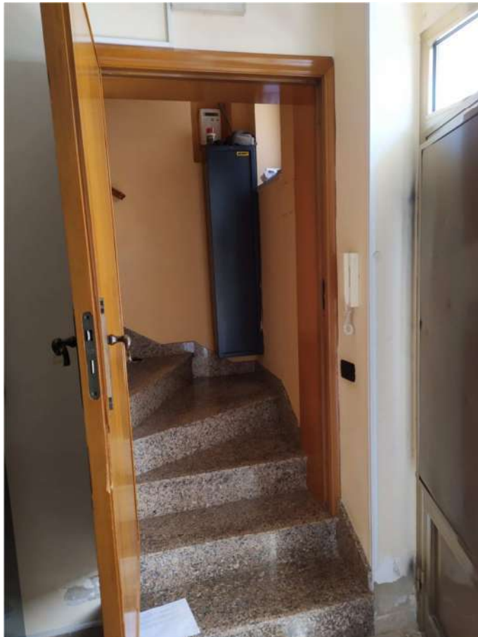
Foto 16 _ Lotto n. 2 _ Gradini di invito vano-scala a pianterreno
