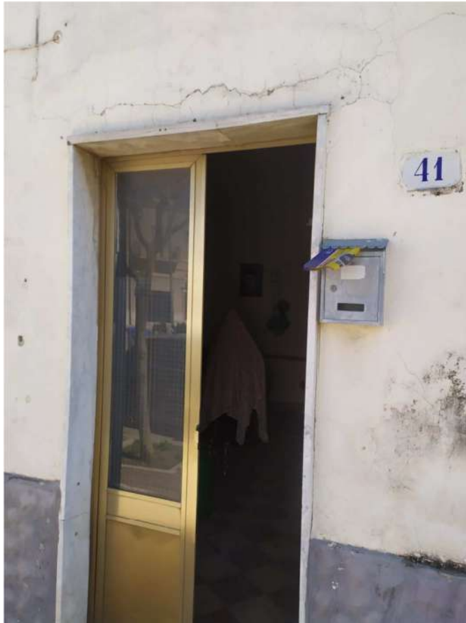
Foto 3 _ Lotto n. 1 _ Porta di accesso su c.so Garibaldi n. 41
