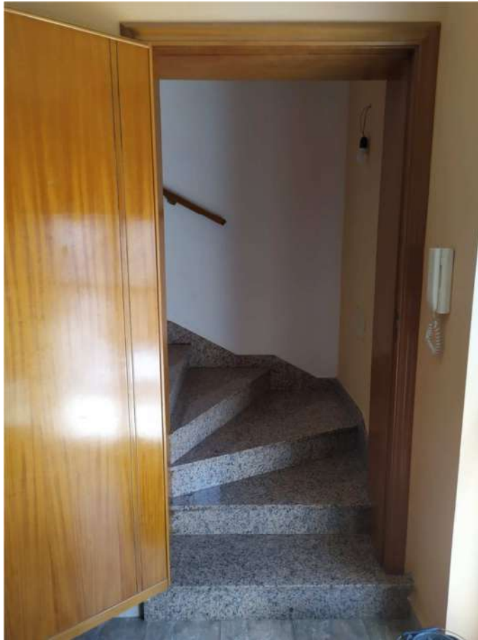
Foto 23 _ Lotto n. 2 _ Gradini di invito vano-scala a primo piano
