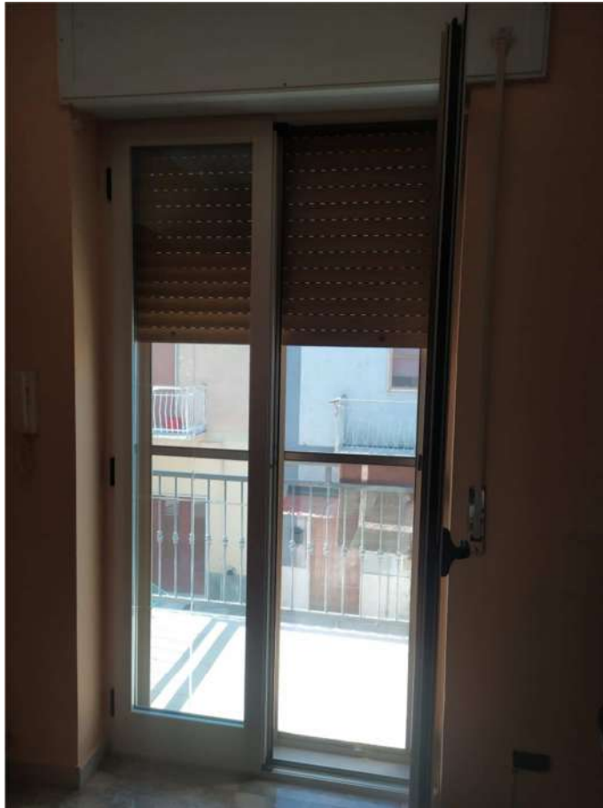
Foto 21 _ Lotto n. 2 _ Particolare infissi a primo piano
