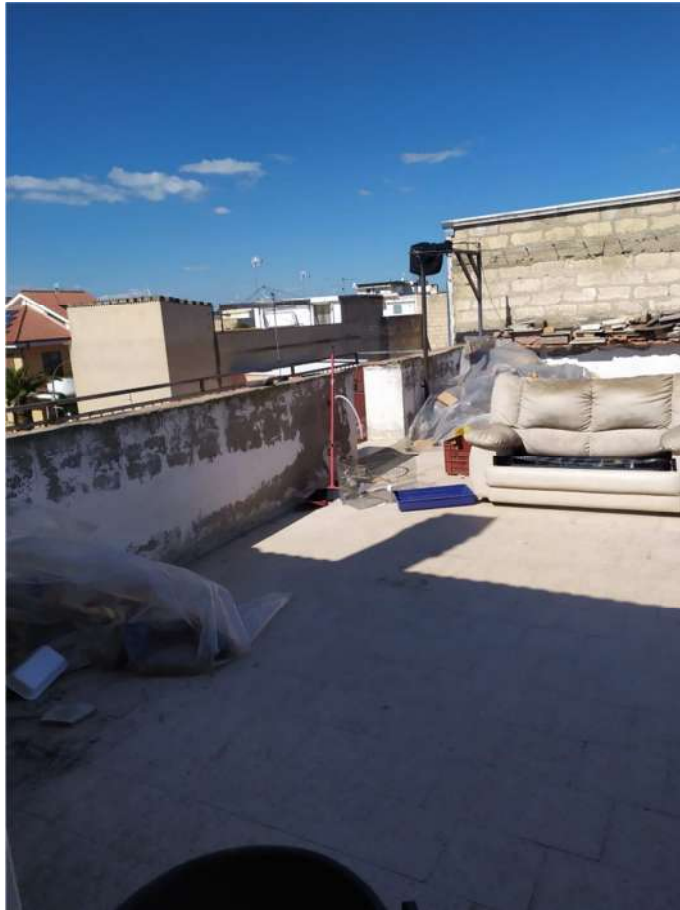
Foto 27 _ Lotto n. 2 _ Terrazzo annesso alla camera d'attico
