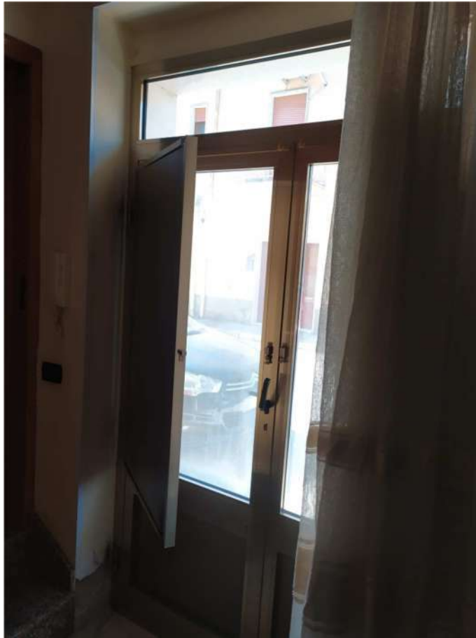
Foto 11 _ Lotto n. 2 _ Particolare porta ingresso a pianterreno
