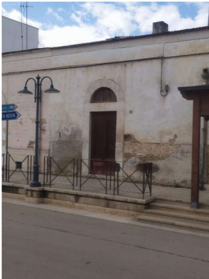
Foto 2 _ Lotto n. 1 _ Facciata del pianterreno su Via Roma n. 46
