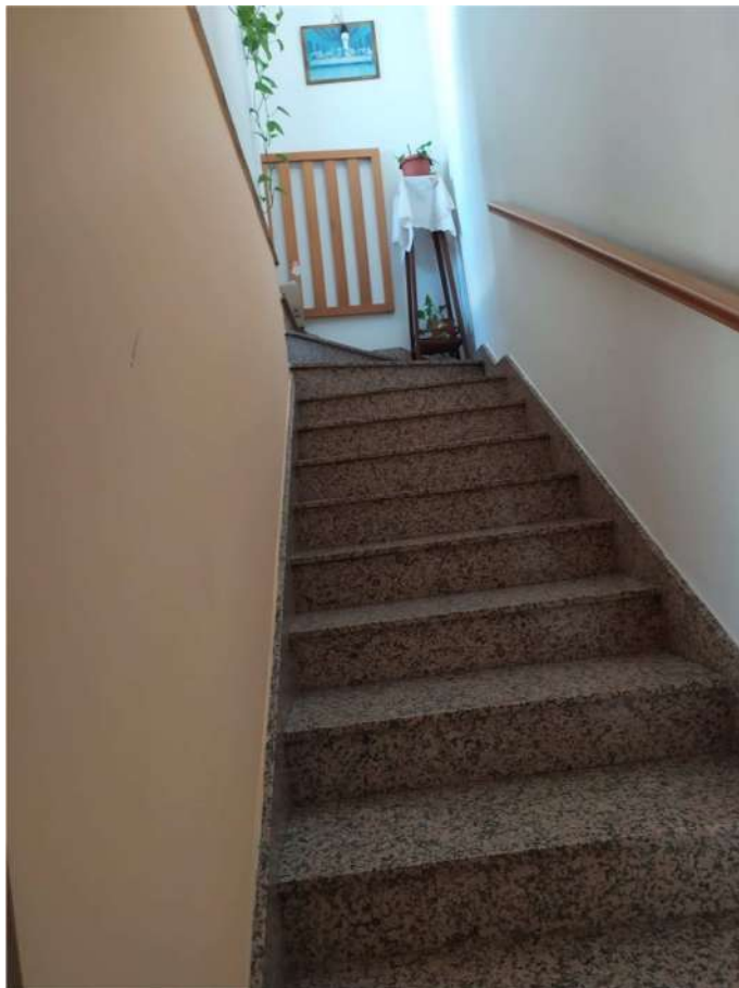
Foto 24 _ Lotto n. 2 _ Rampa scala di accesso alla camera d'attico a secondo piano
