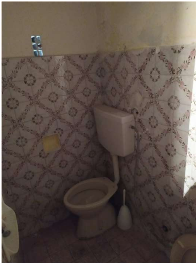
Foto 8 _ Lotto n. 1 _ Rivestimento pareti w.c.
