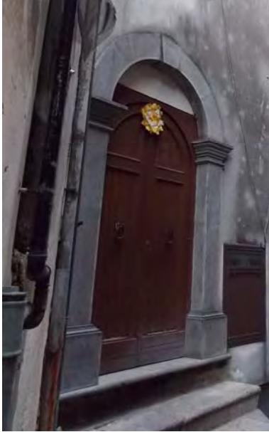
(Viste su ingresso - abitazione)
