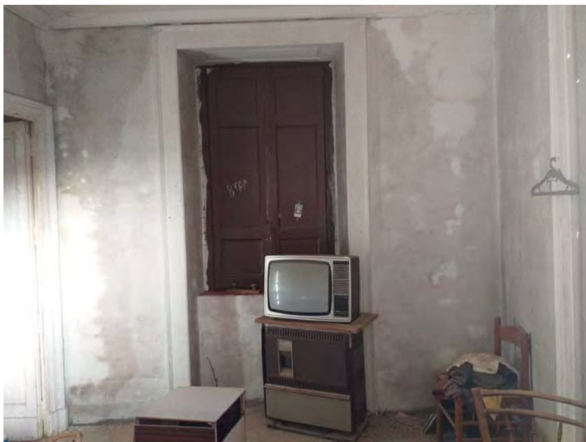
(Viste interne - Vano3)
