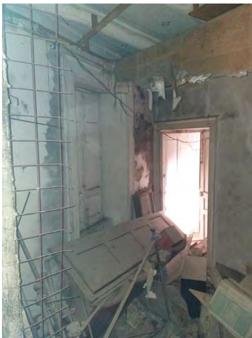
(Vista interna - Vano1)
