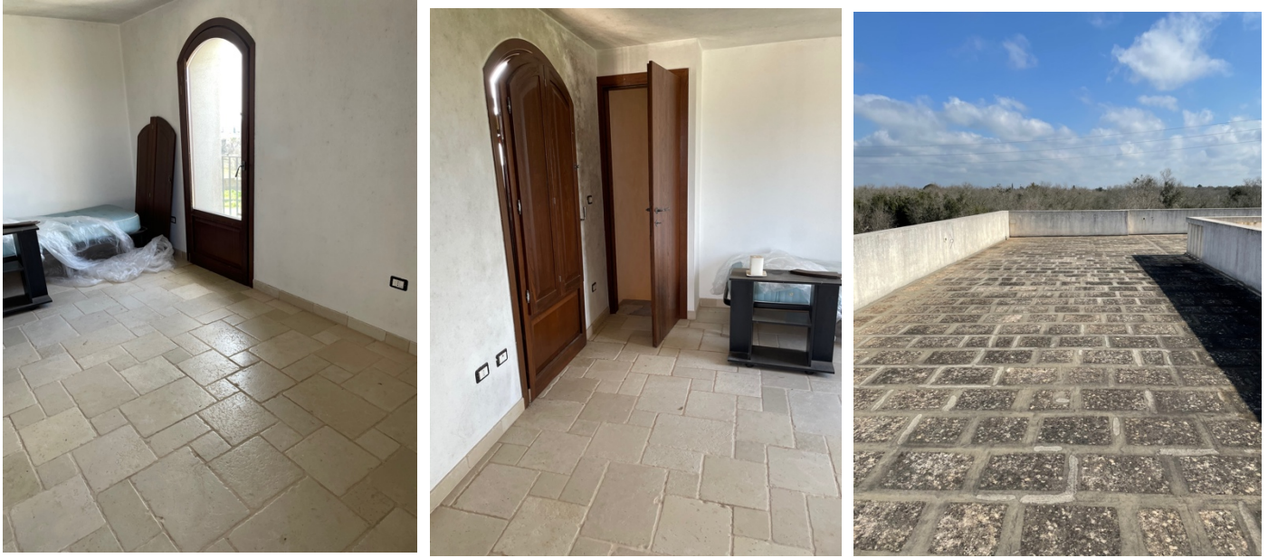
Figura 30: Lotto 1 – Corpo 1 Civile Abitazione P.T.-1-S1 accatastata come “in costruzione” e sita in Ruffano (LE) Località Galeazzi s.n.c. distinta nel NCT al Foglio 25 , Particella 234 – primo piano stanza e lastricato copertura piano terra
