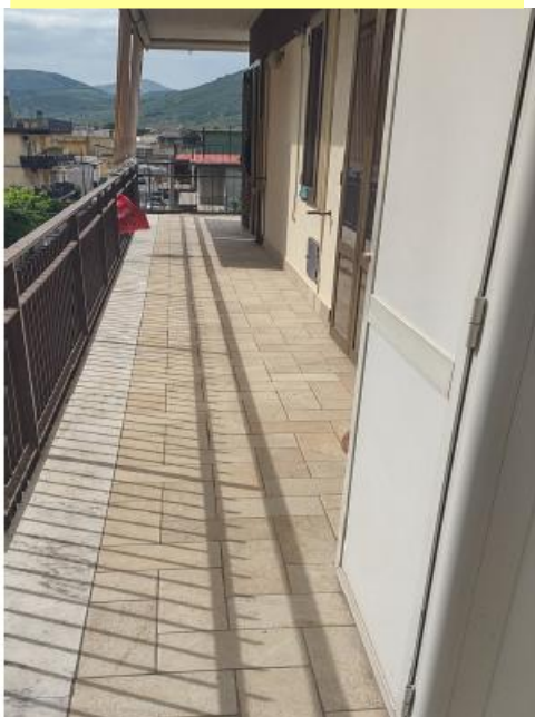
Particolare balcone - Foto n. 8
