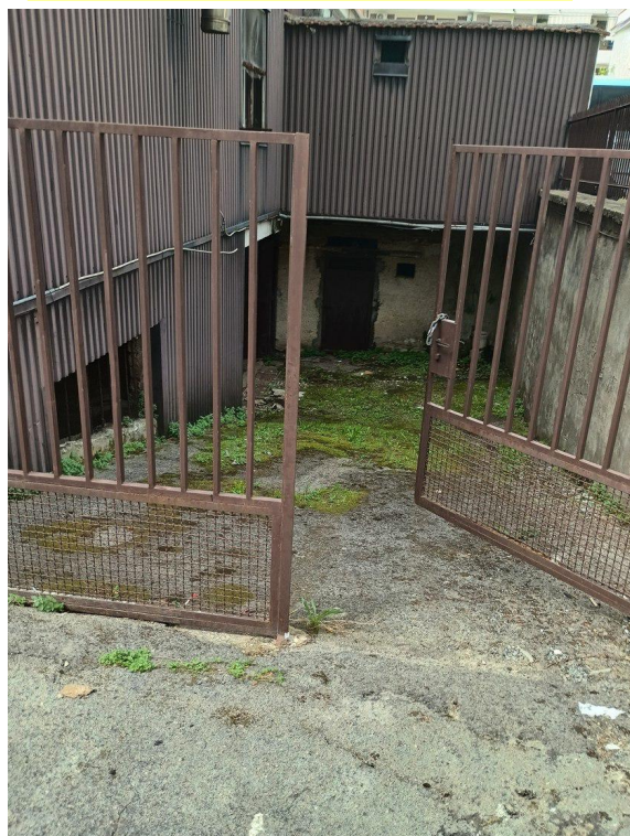
Rampa carrabile P.LLA N. 1387 - Foto n. 3
