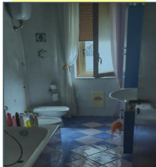
Particolare W.C. - Foto n. 10.
