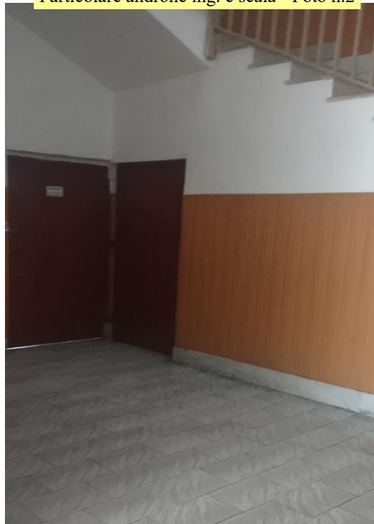
Particolare androne ing. e scala - Foto n.2
