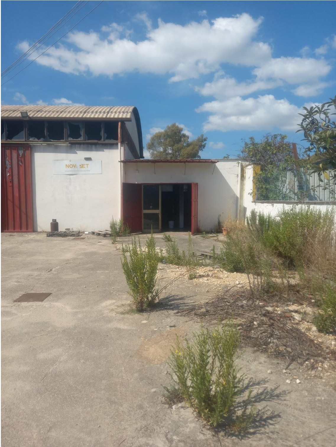
Vista esterna ravvicinata del Fabbricato A sul magazzino posteriore
