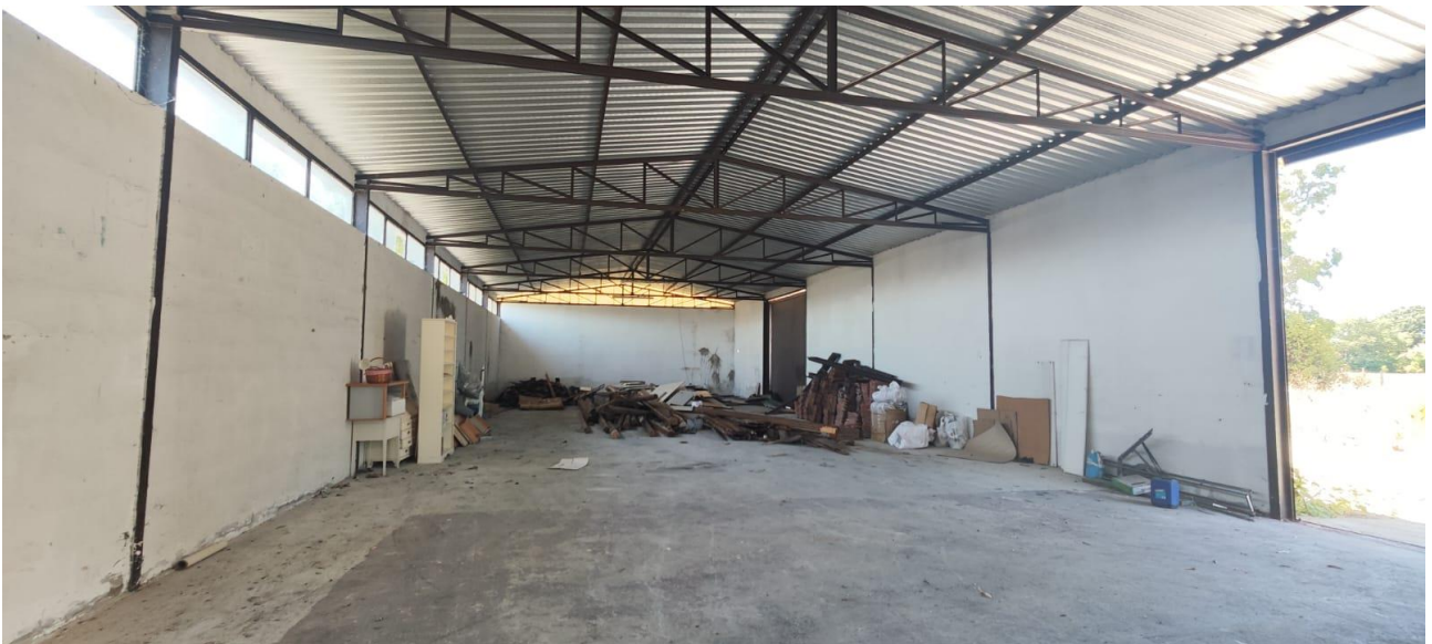
Vista interna del Fabbricato B (lato zona deposito)
