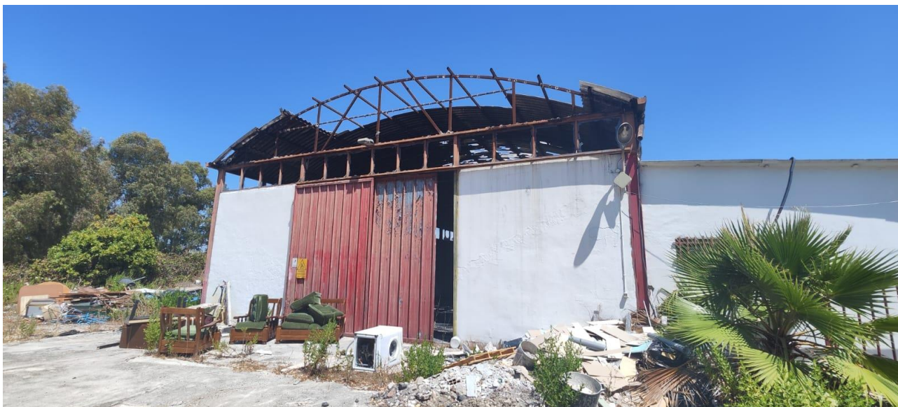
Vista esterna ravvicinata del Fabbricato A sul fronte principale del capannone
