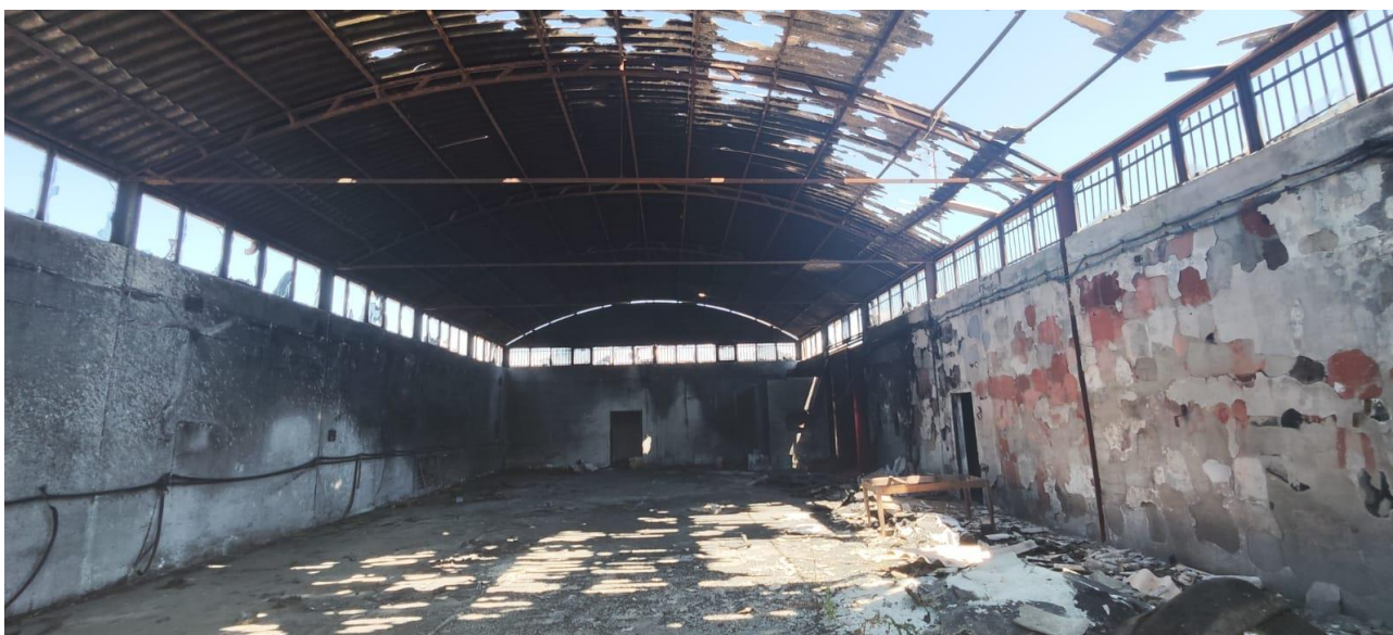
Vista interna del capannone principale del Fabbricato A
