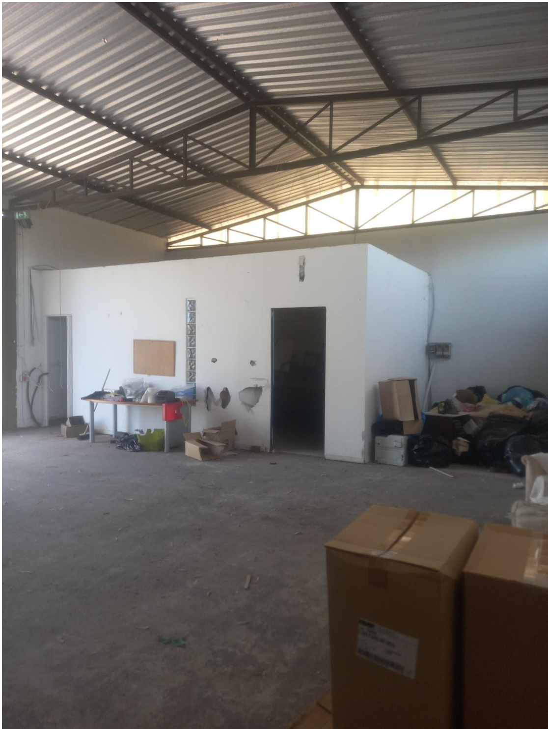
Vista interna del Fabbricato B (lato reparto ambienti di servizio)
