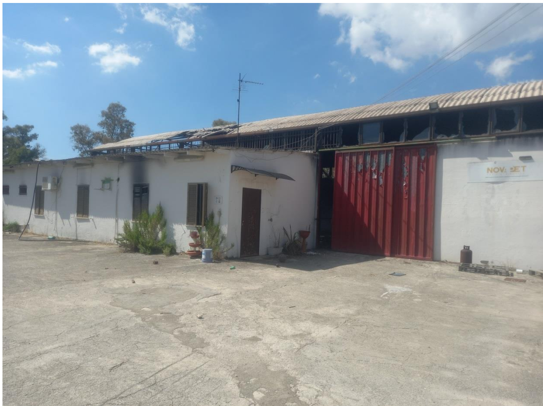
Vista esterna ravvicinata del Fabbricato A sul corpo uffici
