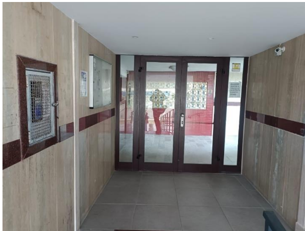
FOTO N.4 – Portone di ingresso
