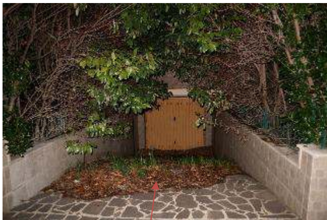
Rampa carrabile con accesso al piano seminterrato
