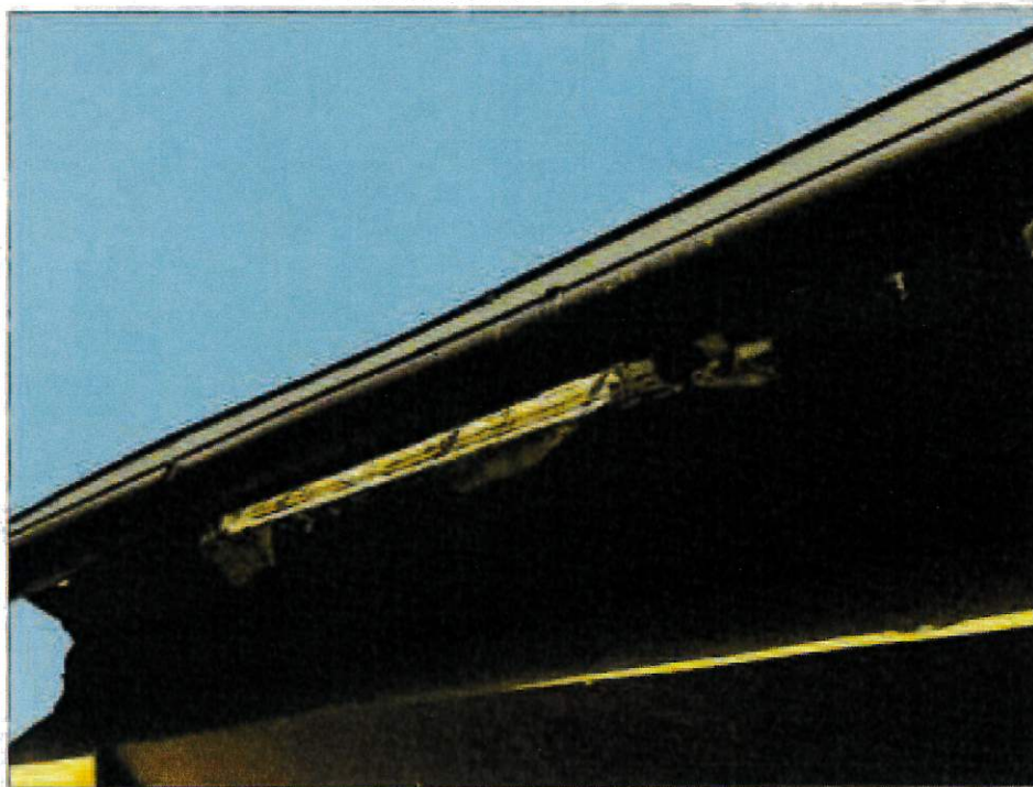
CORNICIONE DA RIPRISTINARE
