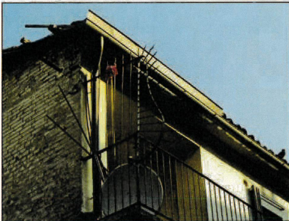
CORNICIONE DA RIPRISTINARE
