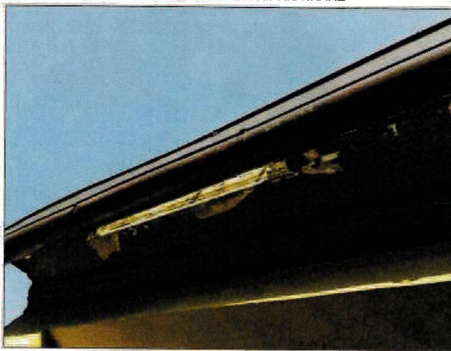
CORNICIONE DA RIPRISTINARE
