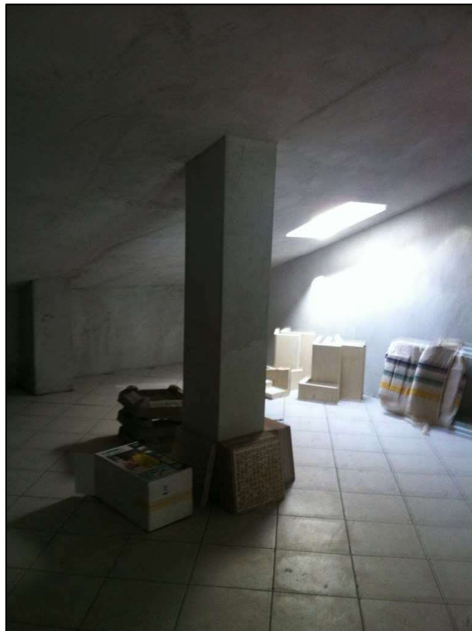
FOTO 45 (interni piano sottotetto)
