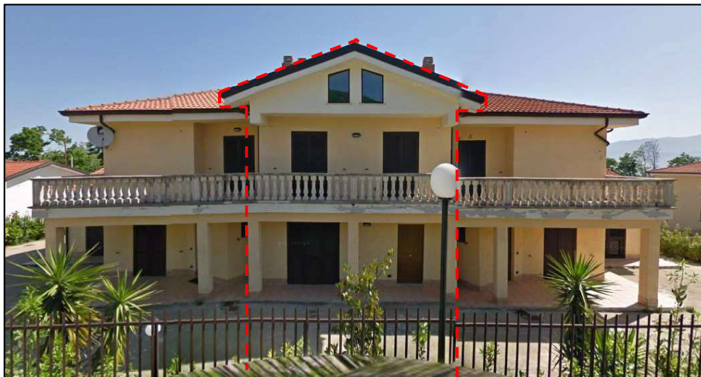
FOTO 4 (esterni lato Sud-Ovest piano terra)
