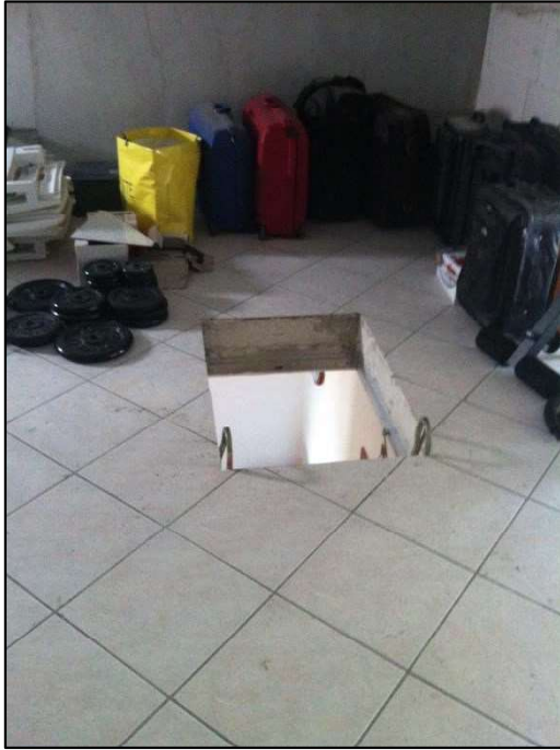
FOTO 43 e 44 (interni piano sottotetto)
