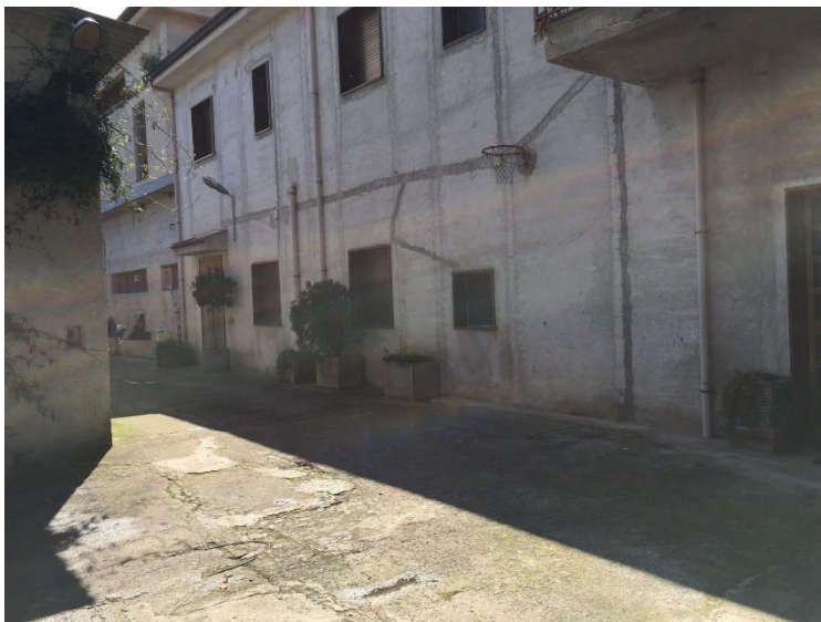
Foto n. 1 - Prospetto nord-est (Corpo A)
