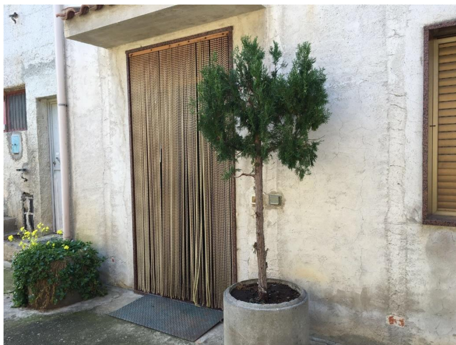
Foto n. 2 - Ingresso zona selezione - confezionamento uova (Corpo A)
