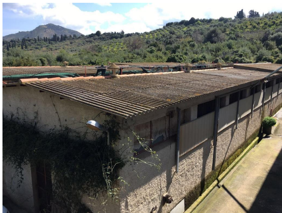
Foto n. 78 - Prospetti Corpo B
