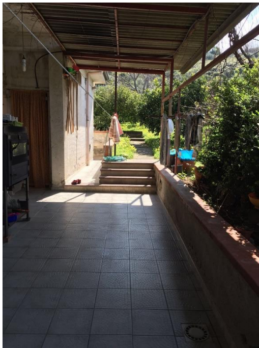
Foto n. 11 - Porticato (Corpo A)
