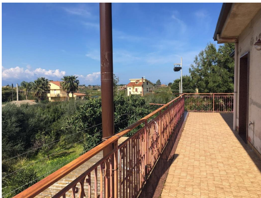
Foto n. 44 - Balcone lato sud-ovest (Corpo A Abitazione - piano primo)
