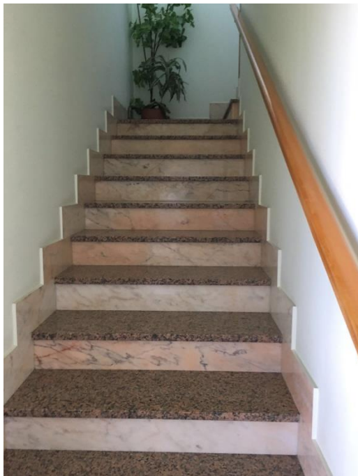
Foto n. 23 - Vano scala (Corpo A Abitazione - piano terra)
