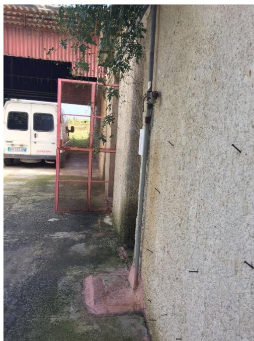
Foto n. 80 - Vista prospetti corpi B e C e tettoia fra i corpi D e G
