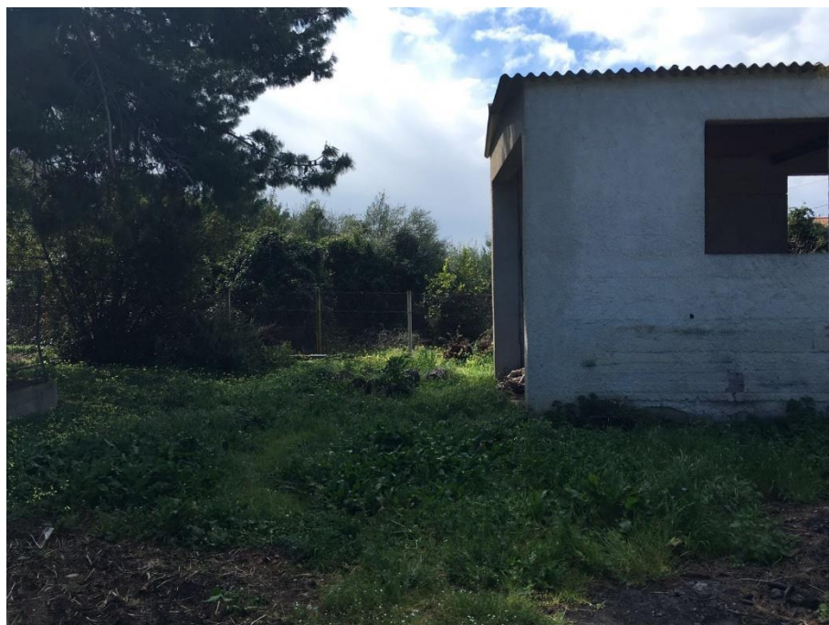
Foto n. 89 - Locale di sgombero (p.lla 2074)
