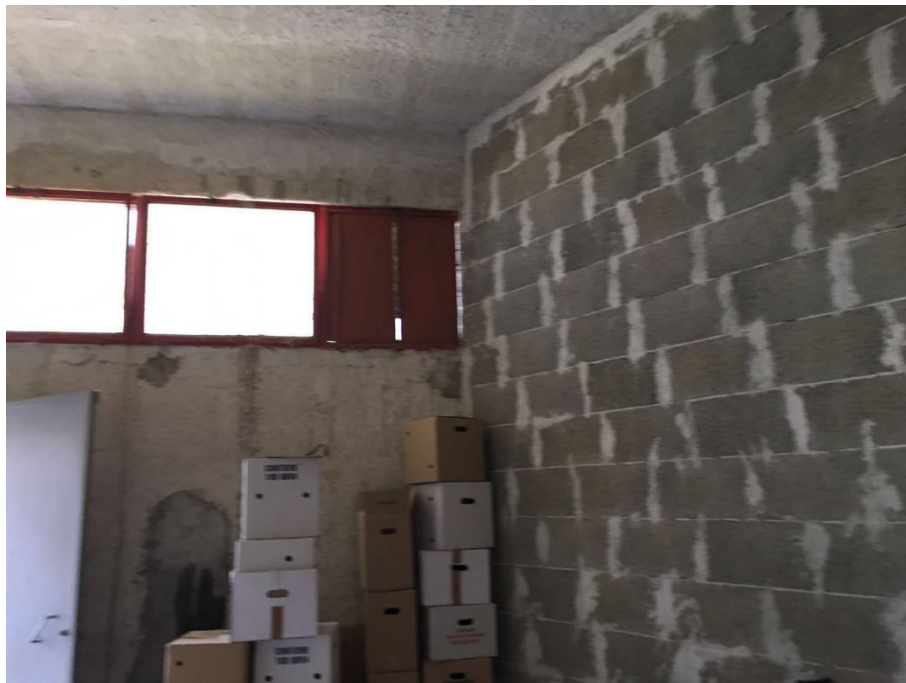
Foton.63- Magazzino 2 (Corpo A cat. D/7 - piano terra)
