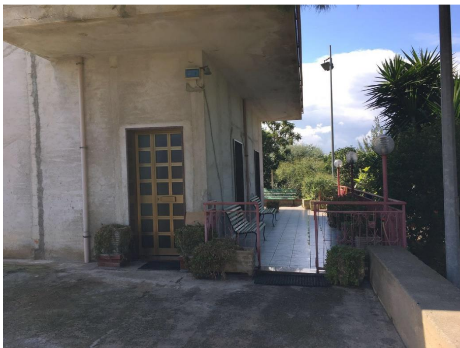
Foto n. 8 - Cortile (Corpo A)
