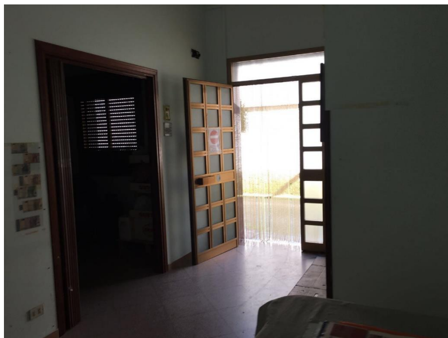
Foto n. 46 - Zona confezionamento Vano 3 (Corpo A cat. D/7 - piano terra)
