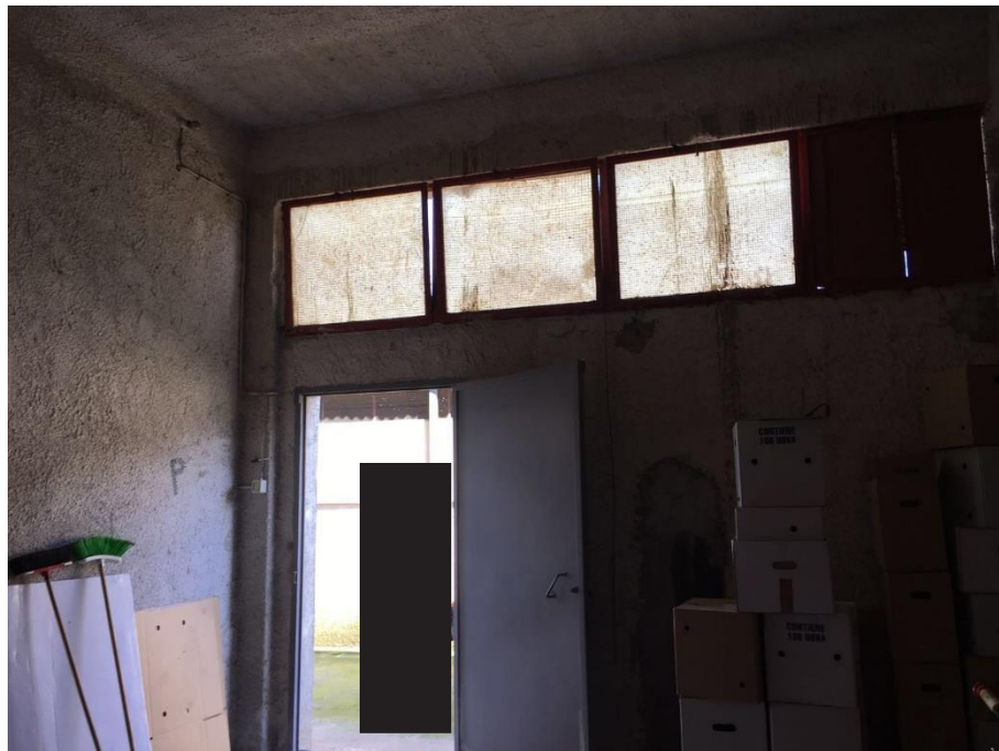
Foton.65- Magazzino 2 (Corpo A cat. D/7- piano terra)
