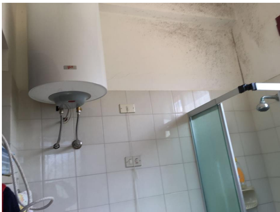
Foto n. 56 -Bagno del personale (Corpo A cat. D/7 - piano terra)
