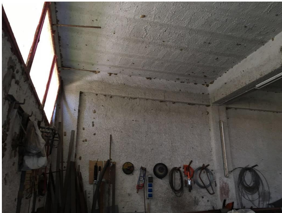
Foton.67-Magazzino 3(Corpo A cat. D/7- piano terra)
