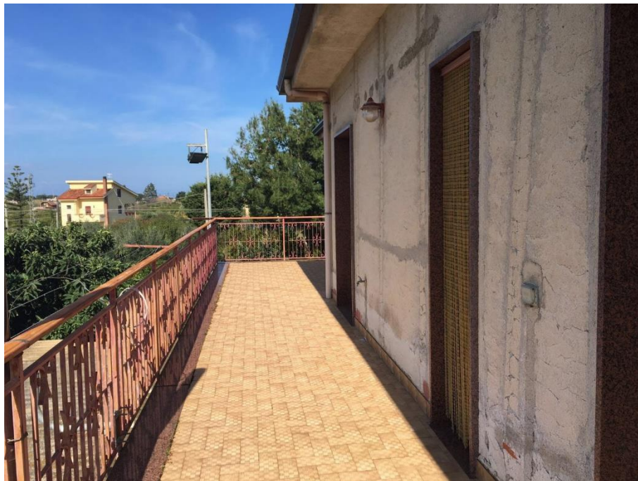
Foto n. 43 - Balcone lato sud-ovest (Corpo A Abitazione - piano primo)
