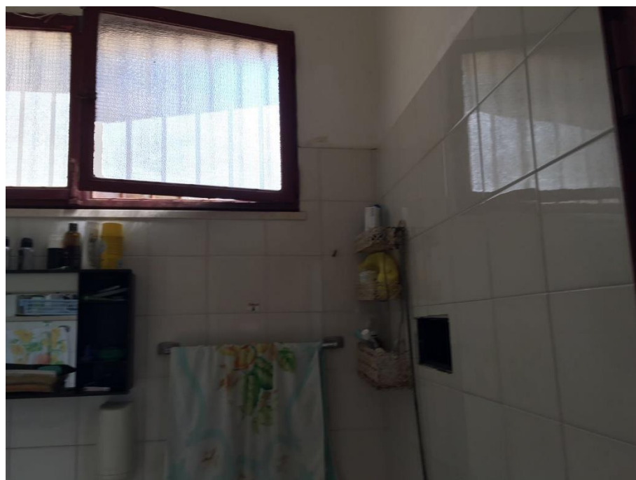
Foto n. 54 - Bagno del personale (Corpo A cat. D/7 - piano terra)
