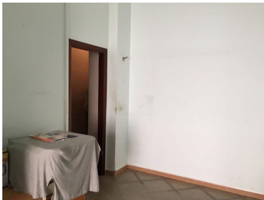
Foto n. 50 - Zona confezionamento Vano 3 (Corpo A cat. D/7 - piano terra)
