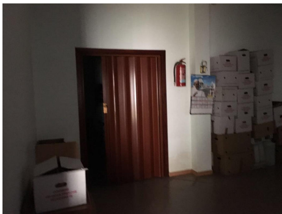
Foto n. 48 - Zona confezionamento Vano 2 (Corpo A cat. D/7 - piano terra)
