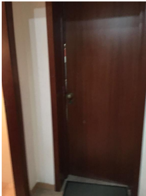
Foto n. 21 - Disimpegno 1 (Corpo A Abitazione - piano terra)
