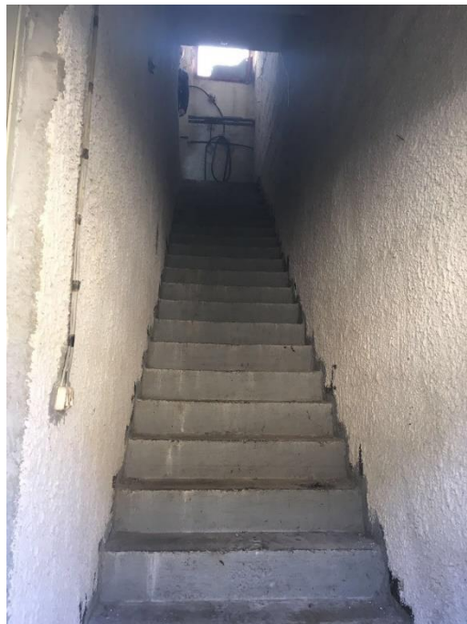
Foto n. 71 - Vano scala A1 (Corpo A cat. D/7 - piano terra)
