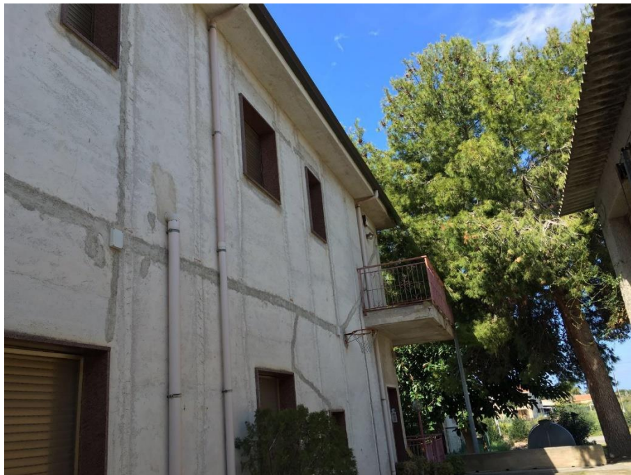
Foto n. 7 - Prospetto nord-est (Corpo A)
