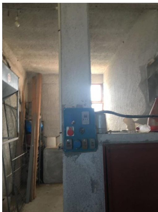
Foto n. 72 - Disimpegno 6 (Corpo A cat. D/7 - piano primo)
