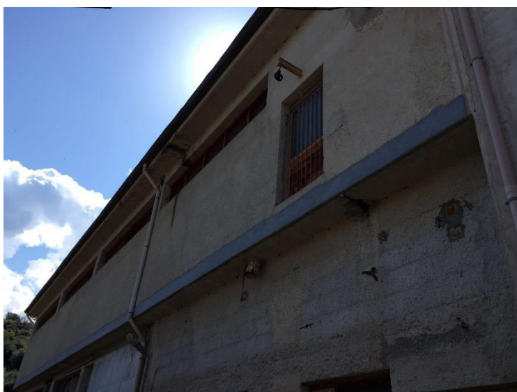
Foto n. 4 - Prospetto nord-est (Corpo A)
