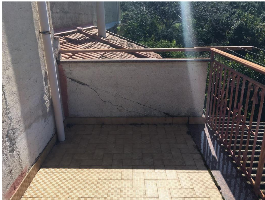
Foto n. 45 - Balcone lato sud-ovest (Corpo A Abitazione - piano primo)
