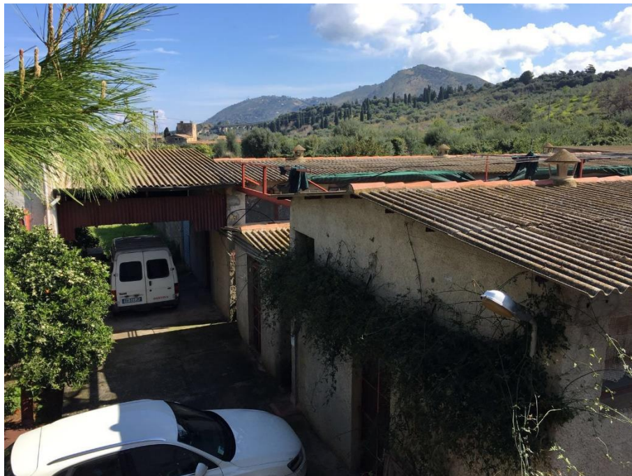
Foto n. 79 - Vista corpi B, C, D e G
