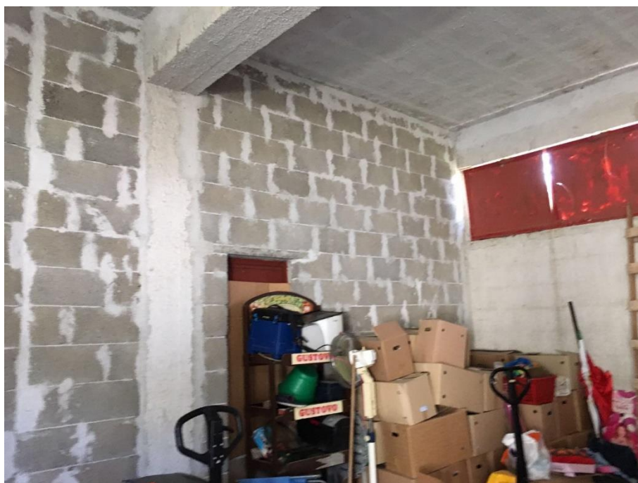
Foton.64- Magazzino 2 (Corpo A cat. D/7 - piano terra)
