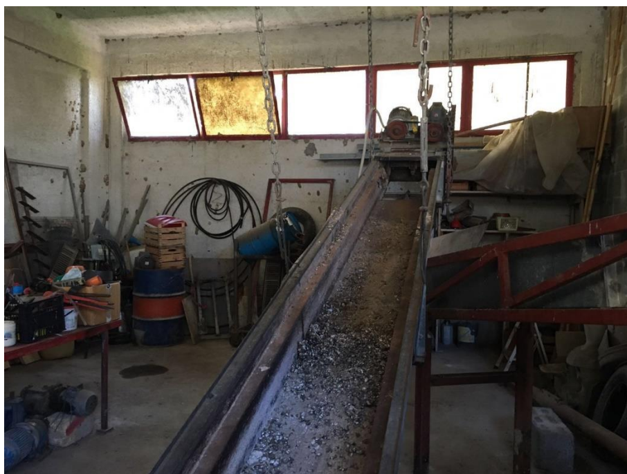
Foton.68-Magazzino 3(Corpo A cat. D/7- piano terra)
