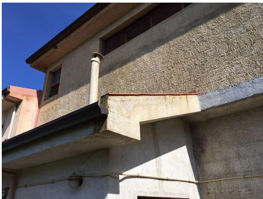
Foto n. 12 - Prospetto sud-ovest (Corpo A)
