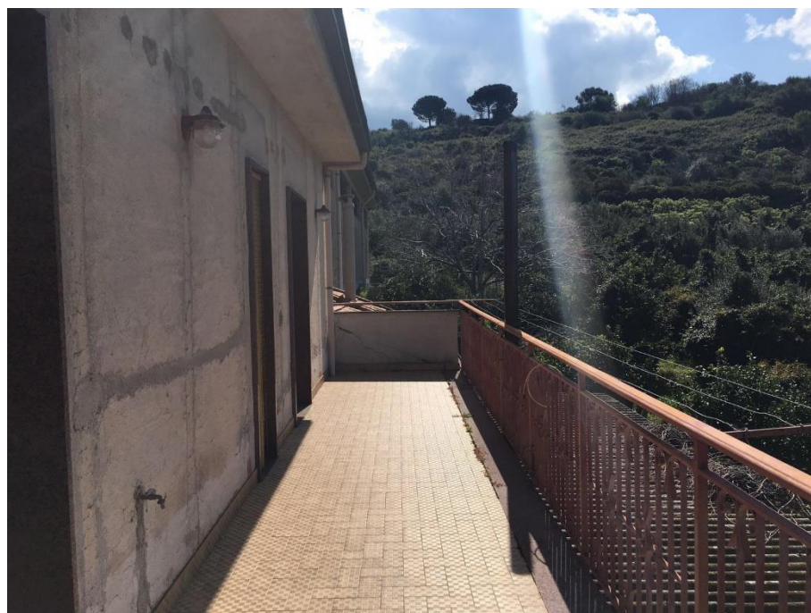
Foto n. 42 - Balcone lato sud-ovest (Corpo A Abitazione - piano primo)
