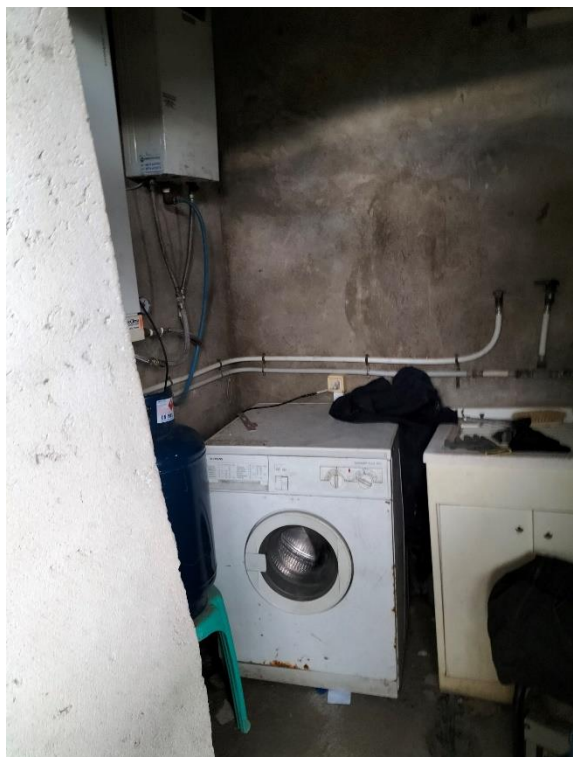
FOTO N. 13 - vano identificato in planimetria catastale ripostiglio esterno
