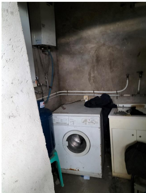
FOTO N. 11 - vano identificato in planimetria catastale ripostiglio esterno
