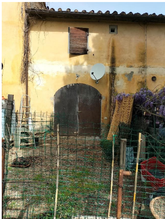
FOTO N. 1 - esterno lato sud-est
