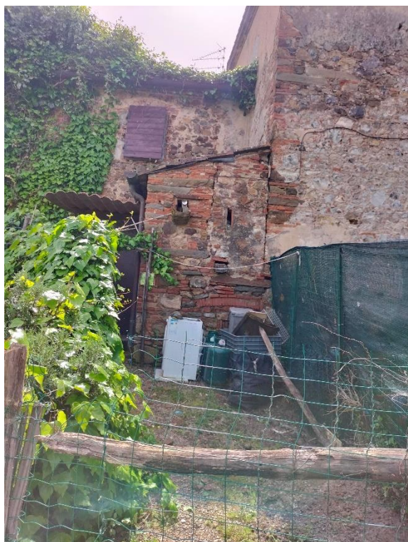
FOTO N. 2 - esterno lato nord-ovest
