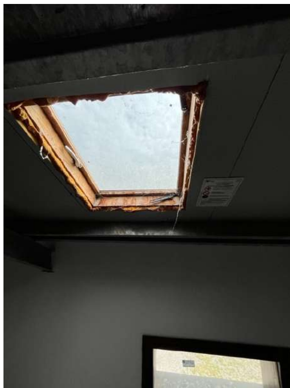
Fotografia 43 – Vista del velux accesso al tetto
