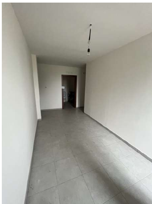
Fotografia 24 – Vista del corridoio
