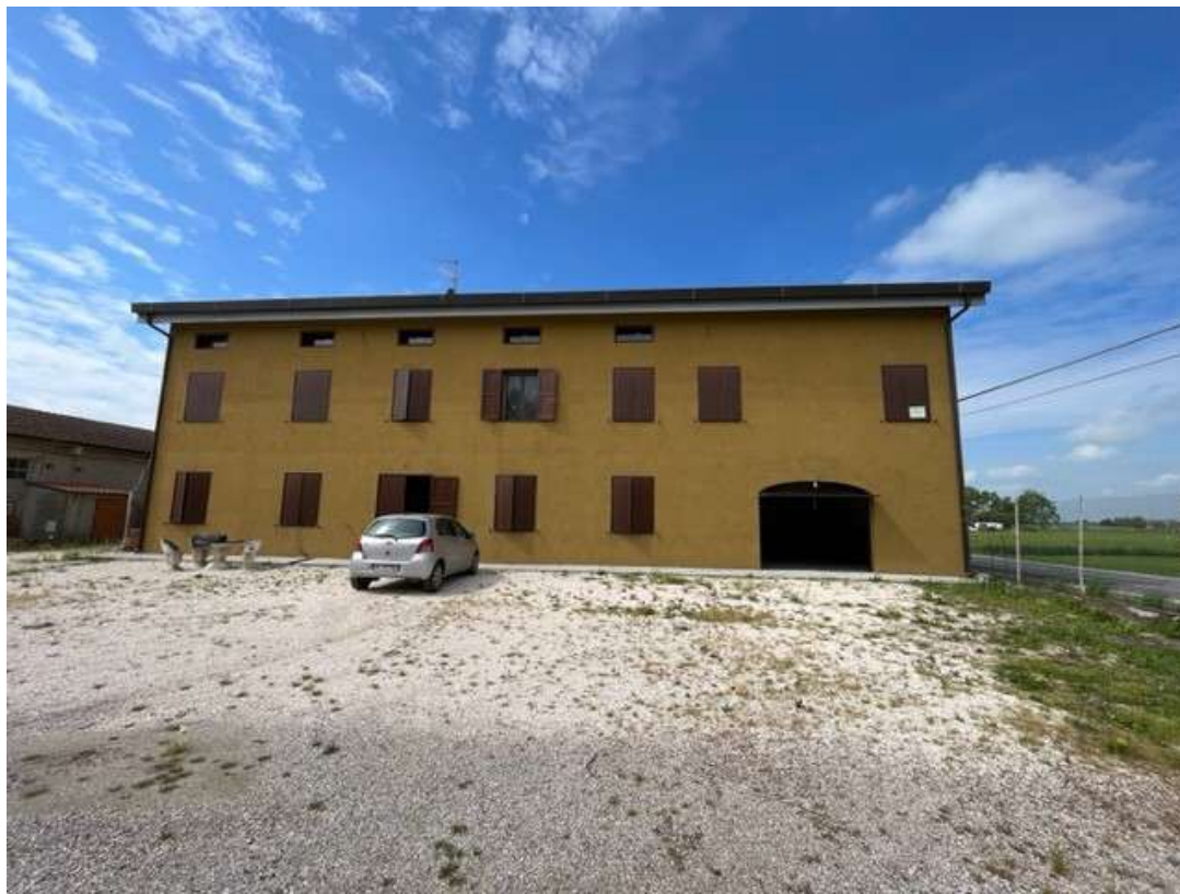
Fotografia 1 – Vista dal cortile di proprietà
