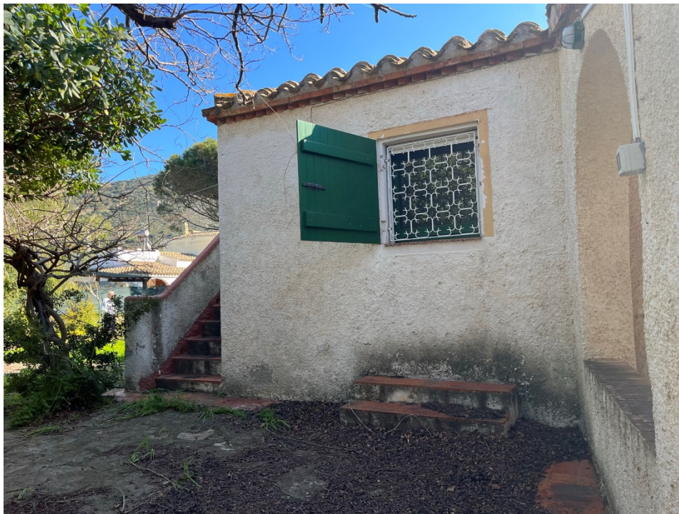
Foto 7 Prospetto ovest – scala di accesso al solarium dul tetto
