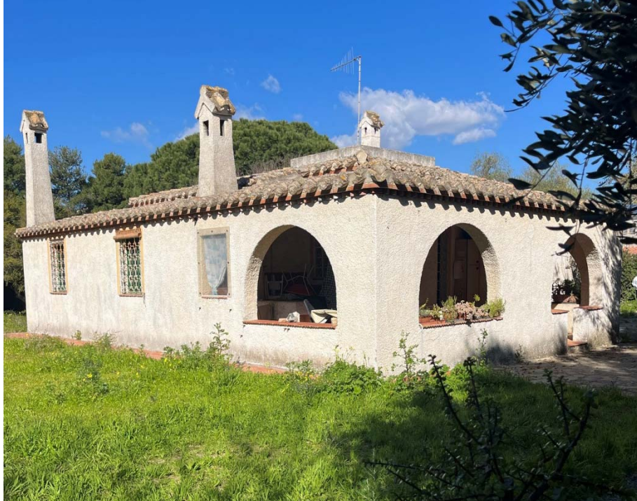
Foto 4 Vista del patio – prospetti sud ed est
