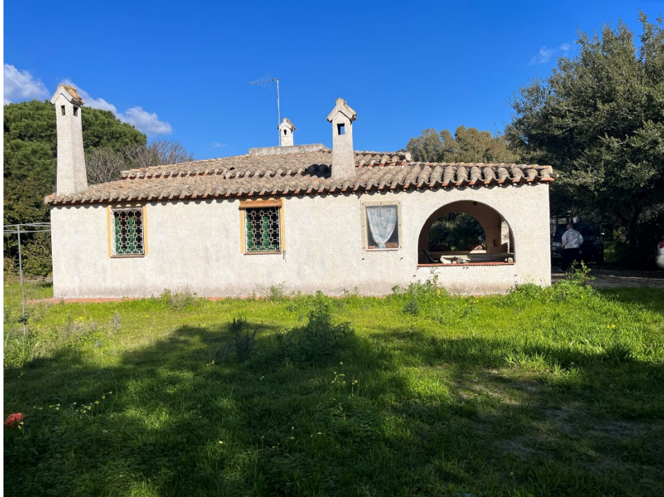
Foto 3 Vista del prospetto sud
