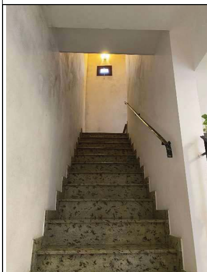
vano scala tra p. primo e p. secondo
