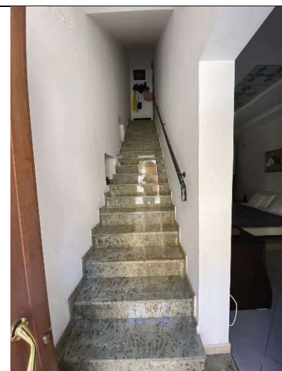
vano scala tra p. terra e p. primo
