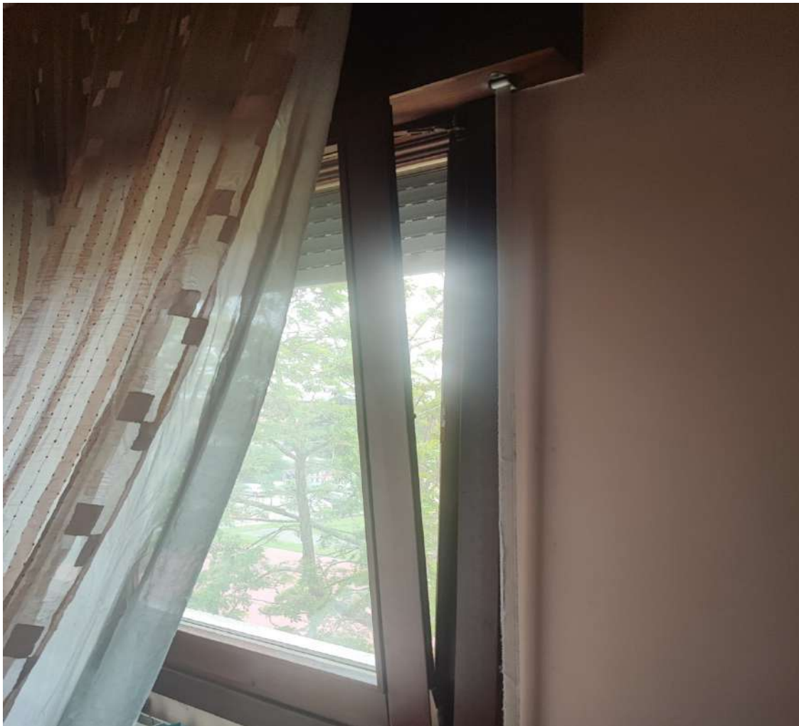
Fotografia n. 27 – Appartamento P. 3 – Infissi
