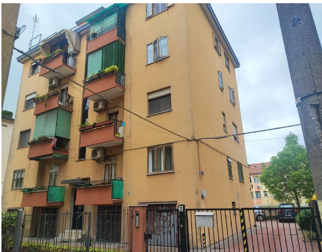
Fotografia n. 02 – Condominio Flora (fronte)
