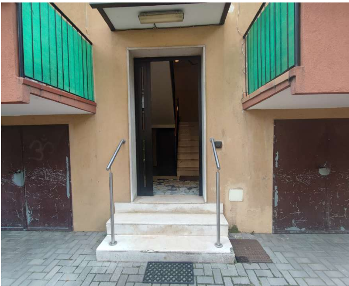
Fotografia n. 06 – Condominio Flora – portone di ingresso condominiale
