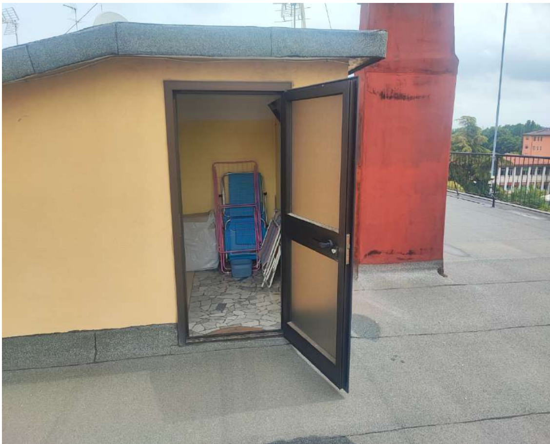
Fotografia n. 29 – Lastrico solare P. 5 – Accesso dal vano scale
