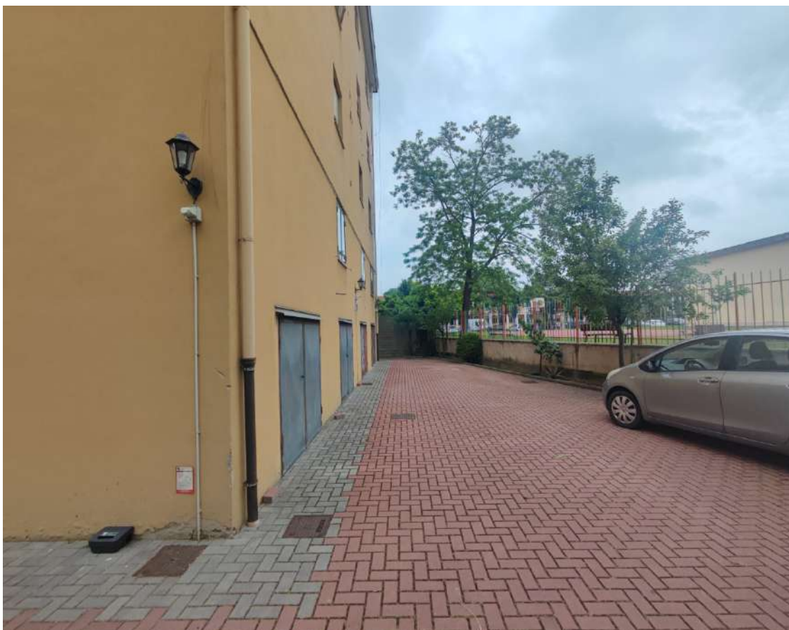
Fotografia n. 04 – Condominio Flora (retro)
