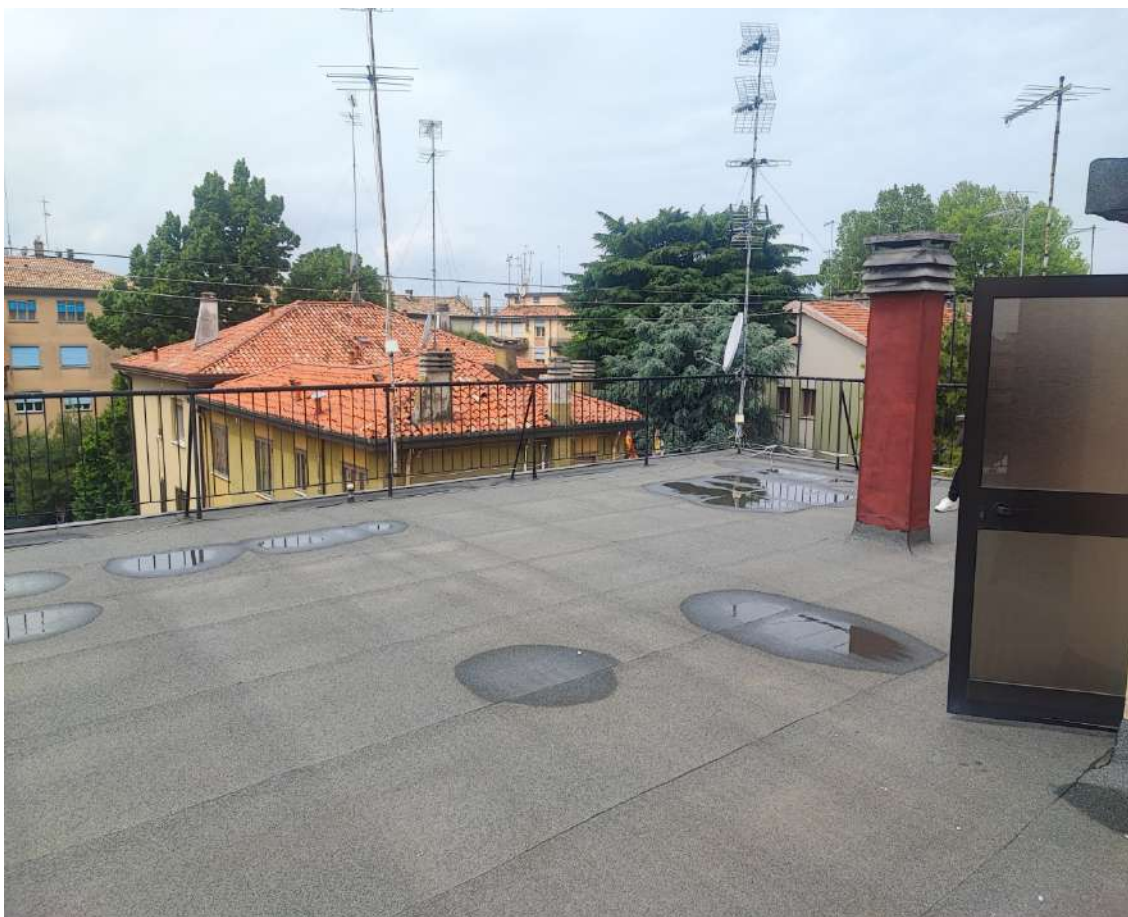
Fotografia n. 30 – Lastrico solare P. 5 – Accesso dal vano scale
