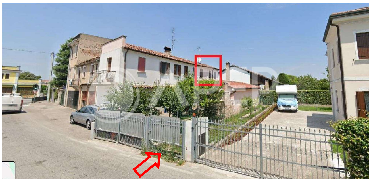
Foto n. 2: Scorcio-Vista fabbricato da via Rena con accesso esclusivo
