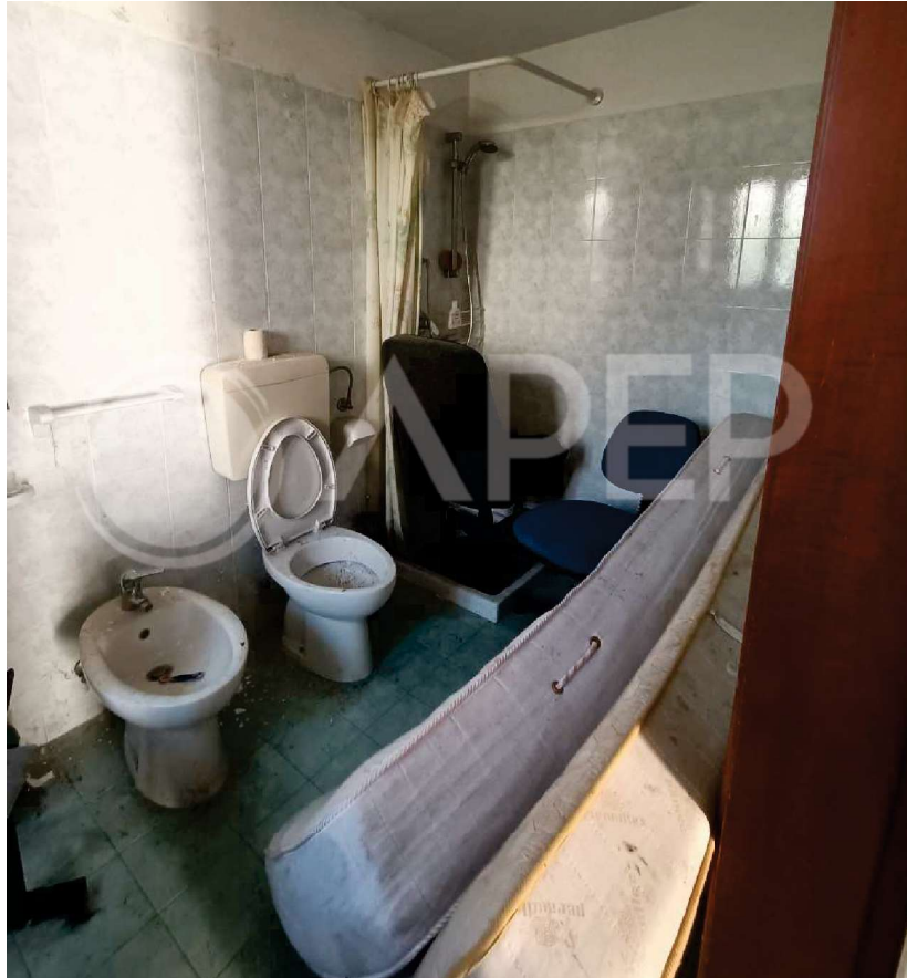
Foto n. 8: Vista bagno piano terra
