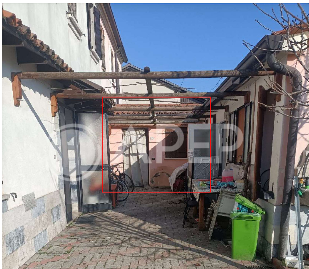
Foto n. 3: Vista portoncini di ingresso da spazio esterno comune
