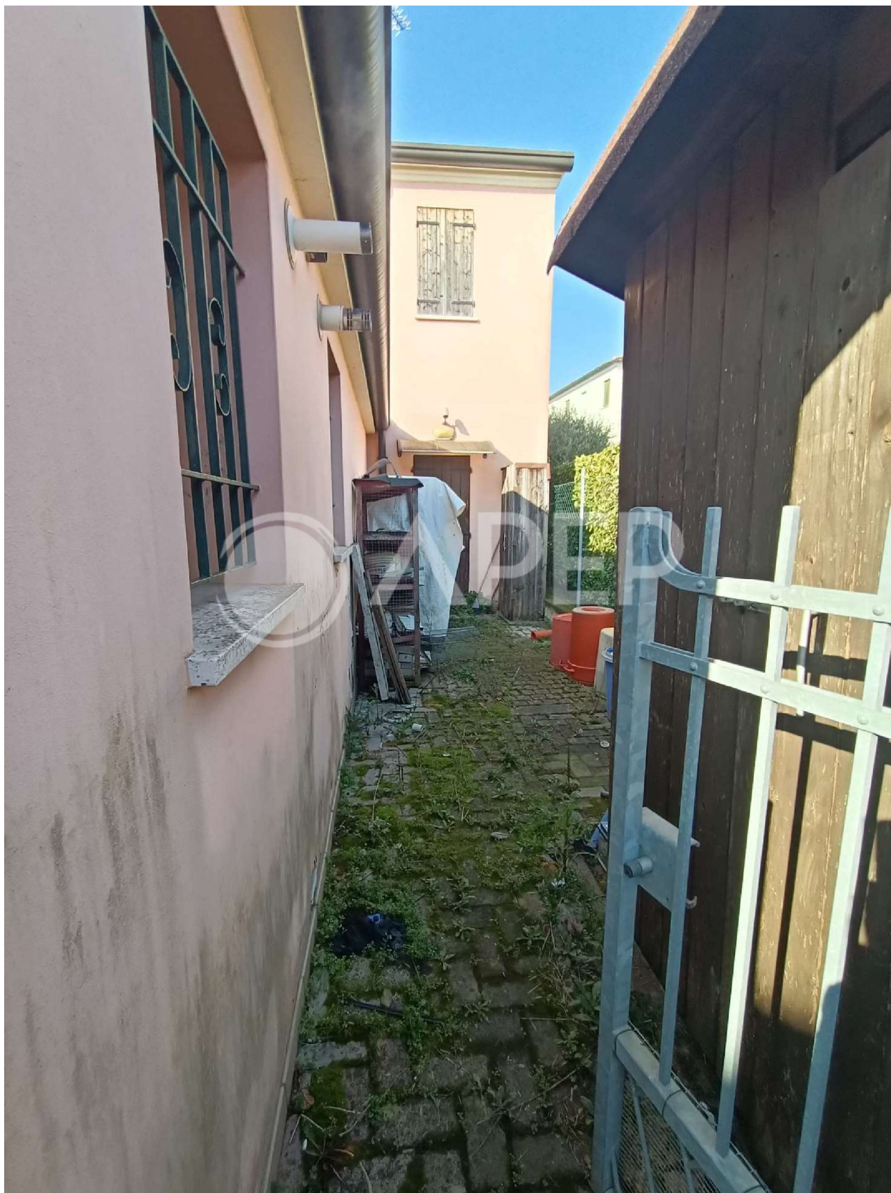
Foto n. 5: Vista percorso ingresso da lato esclusivo
