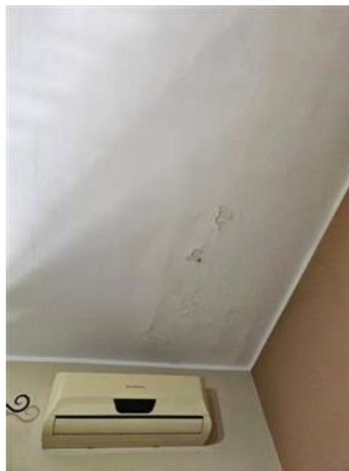
parti di solaio ammalorate camera da letto
