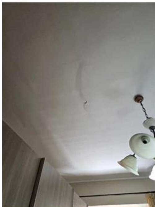
parti di solaio ammalorate camera da letto
