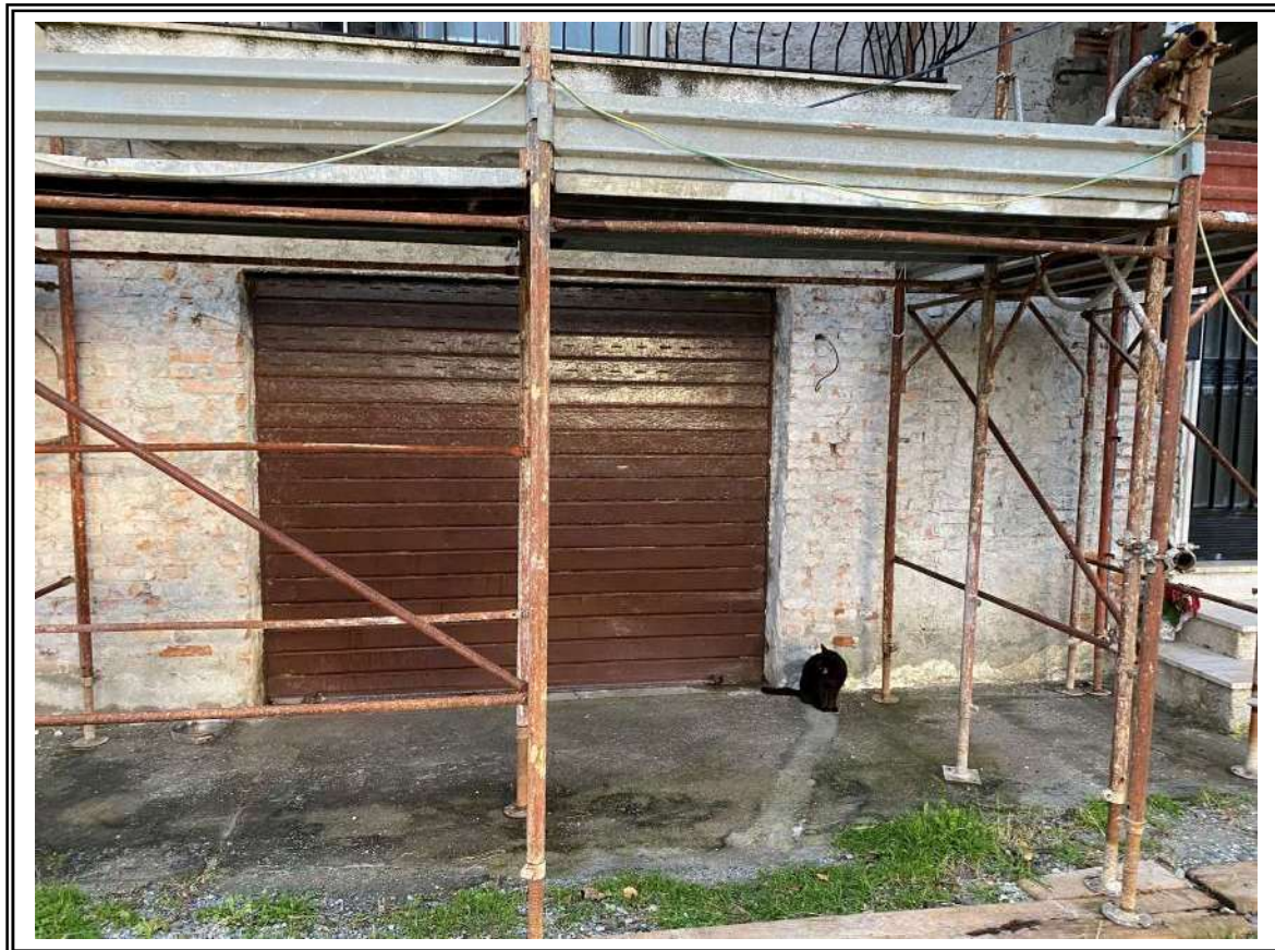
Foto n. 4 – Fabbricato di Contrada Cent'Acque n° 8 – Magazzino/Locale di deposito Piano Terra.
