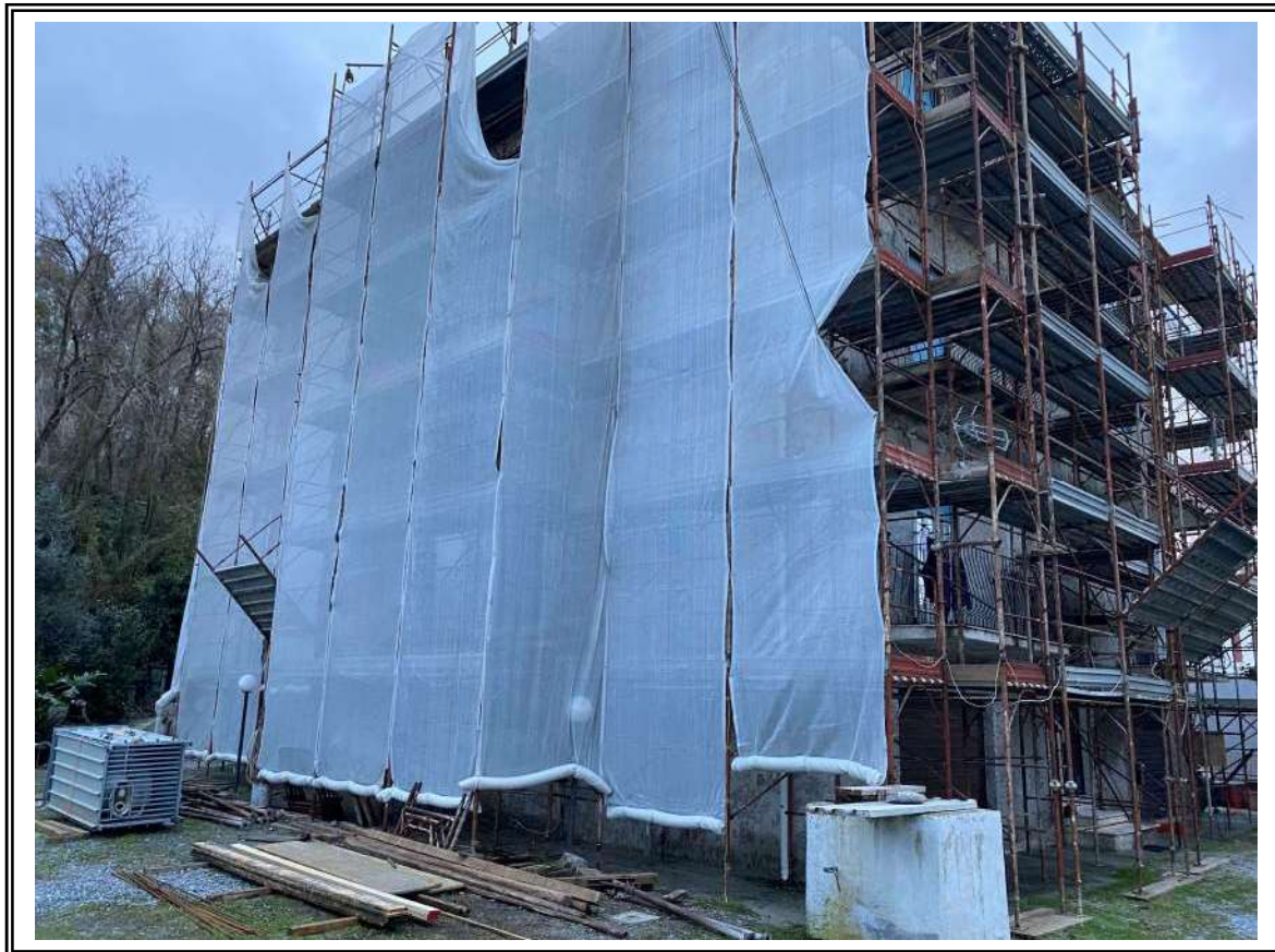
Foto n. 3 – Fabbricato di Contrada Cent'Acque n° 8 – Prospetto Laterale (Nord/Ovest).
