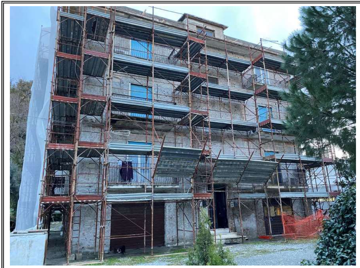
Foto n. 1 – Fabbricato di Contrada Cent'Acque n° 8 – Prospetto Principale (Sud/Ovest).
