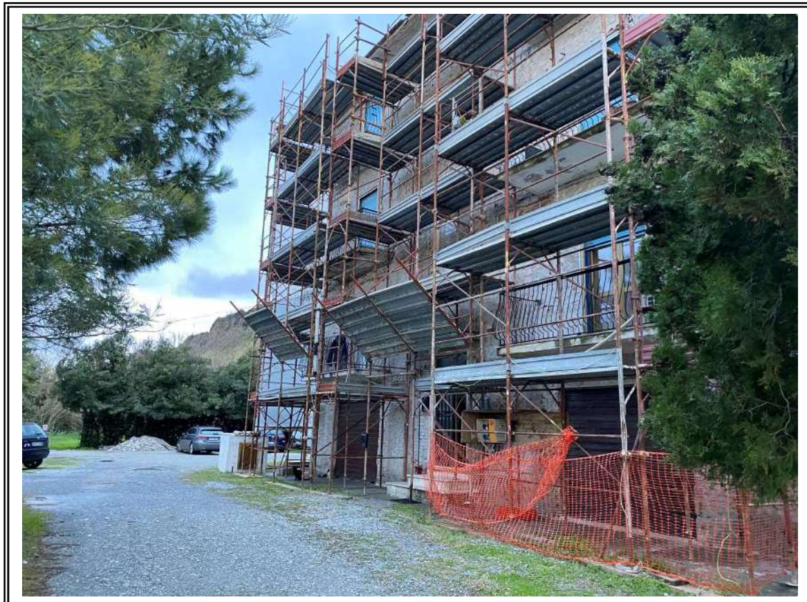
Foto n. 2 – Fabbricato di Contrada Cent'Acque n° 8 – Prospetto Principale (Sud/Ovest).
