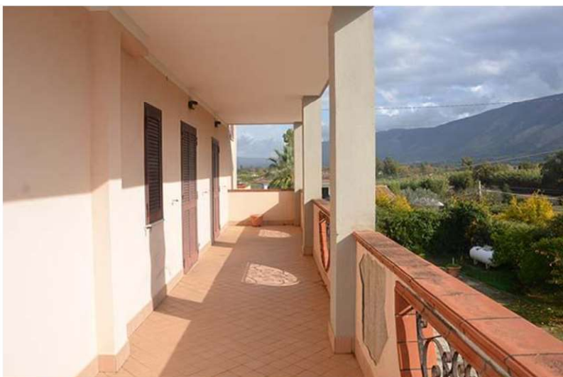
imm2.28: terrazzo coperto fronte principale
