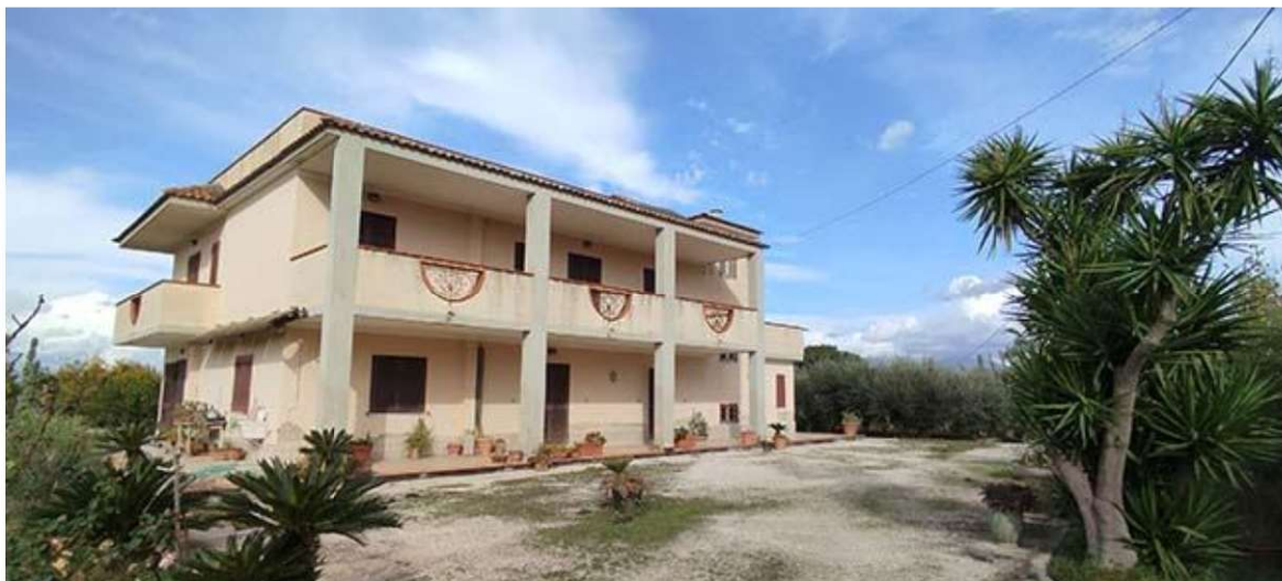
imm2.07: vista del fabbricato dall'ingresso
