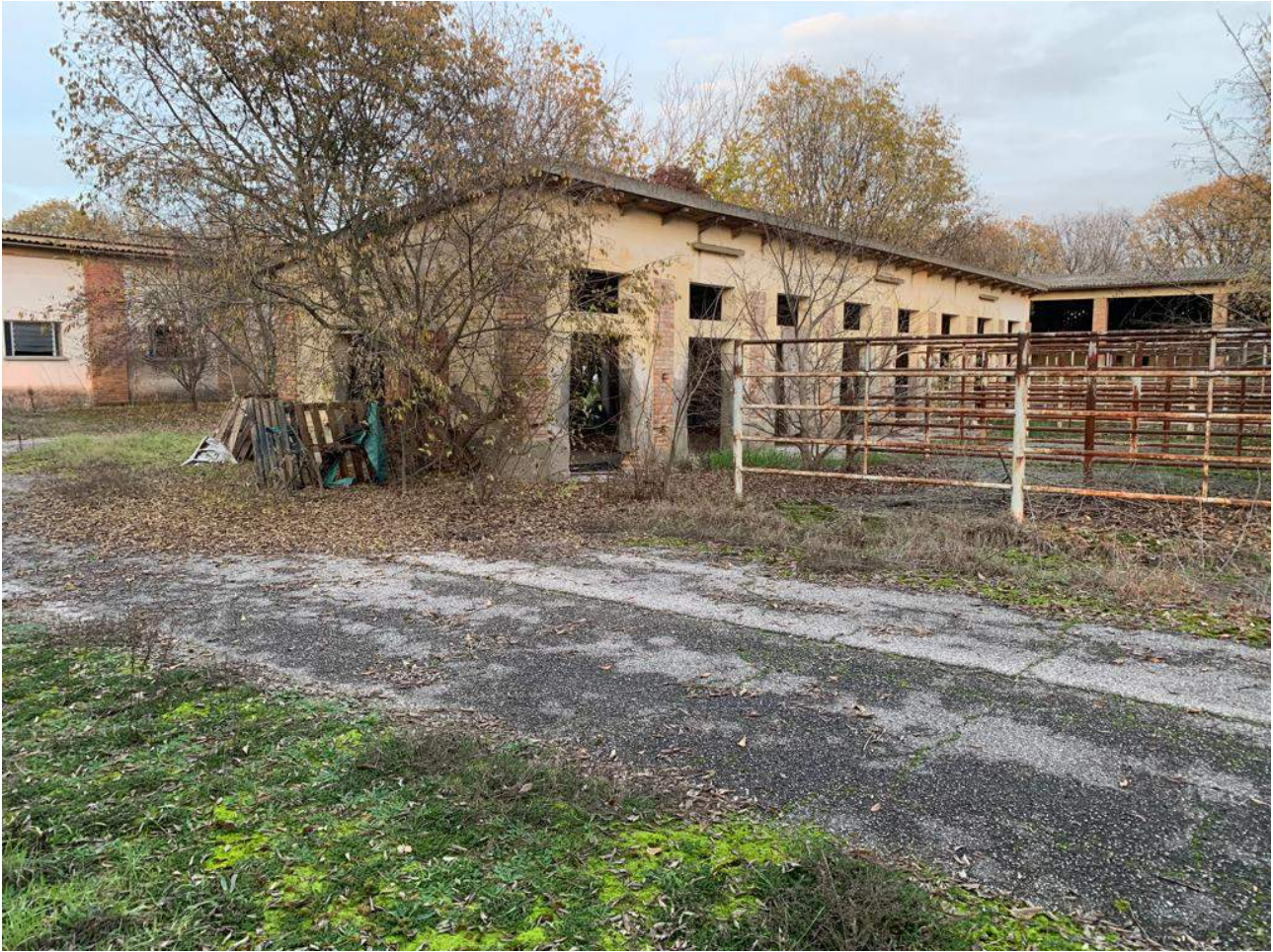
Foto n° 19: corpo 84 da Ovest
