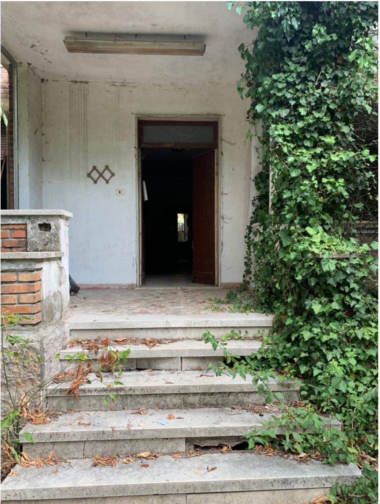
Foto n° 26: Ingresso palazzina Sub 1
