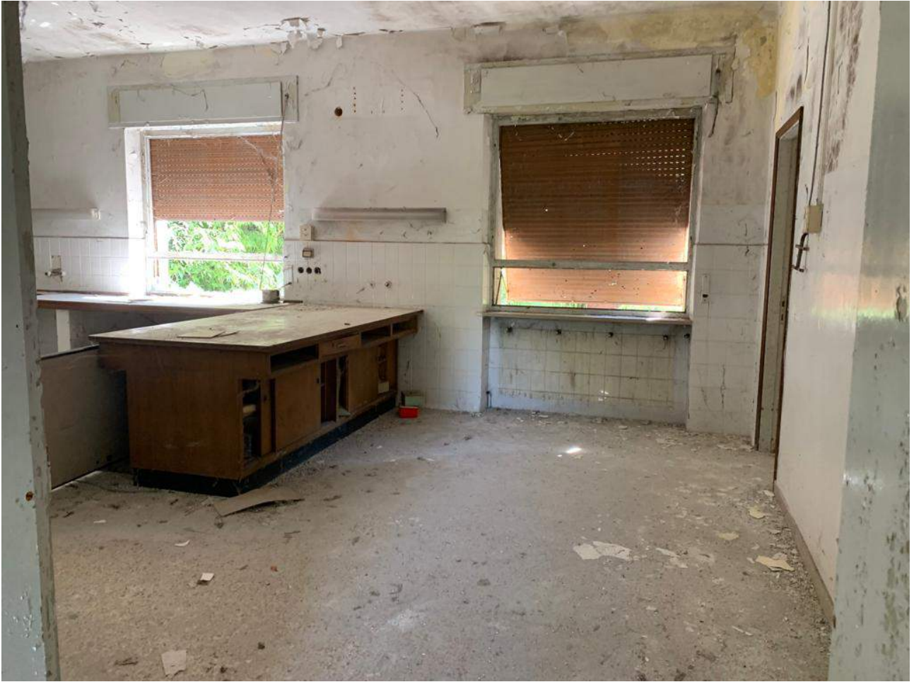
Foto n° 6: Locale corpo principale
