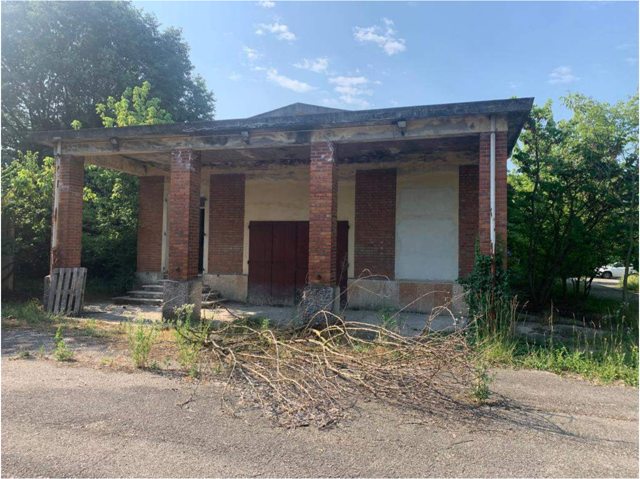
Foto n° 4: Corpo principale lato Nord
