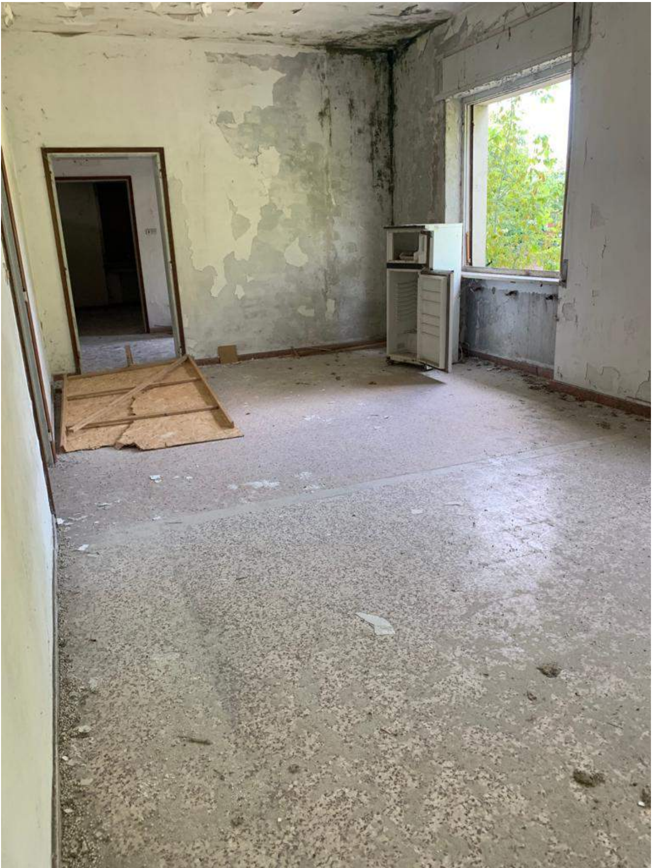
Foto n° 7: Locale corpo principale
