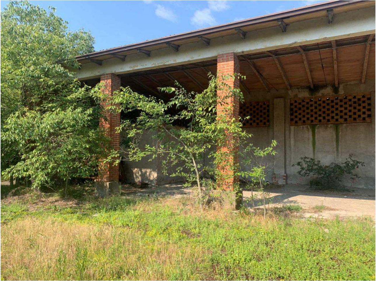
Foto n° 11: Portico particella n. 83
