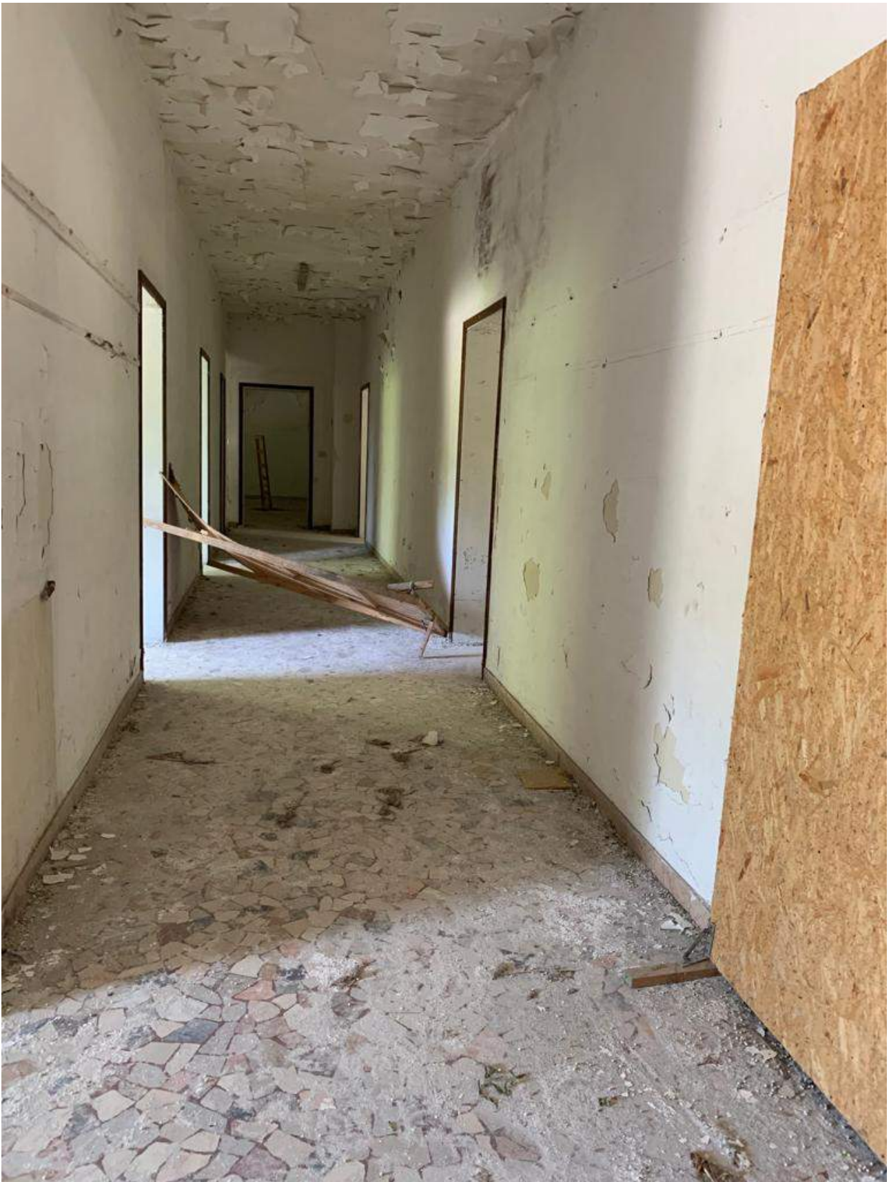
Foto n° 5: Interno corpo principale
