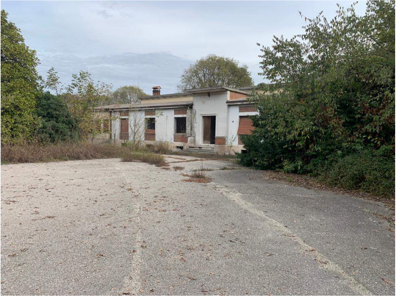
Foto n° 3: Corpo principale lato Ovest
