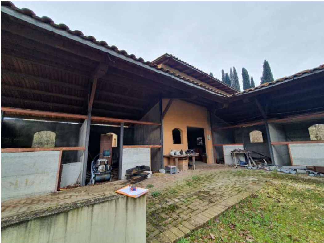
FOTO 37 – Ripresa fotografica blocco C, stalle e parte a monte
