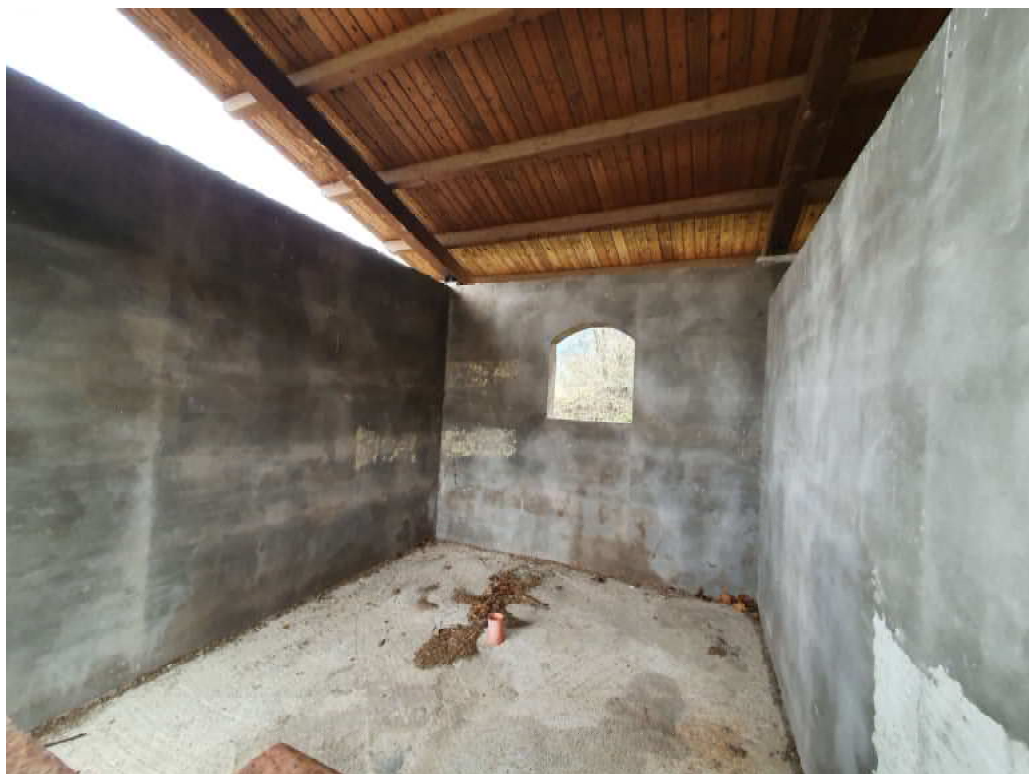
FOTO 40 – Ripresa fotografica blocco C, stalle singole
