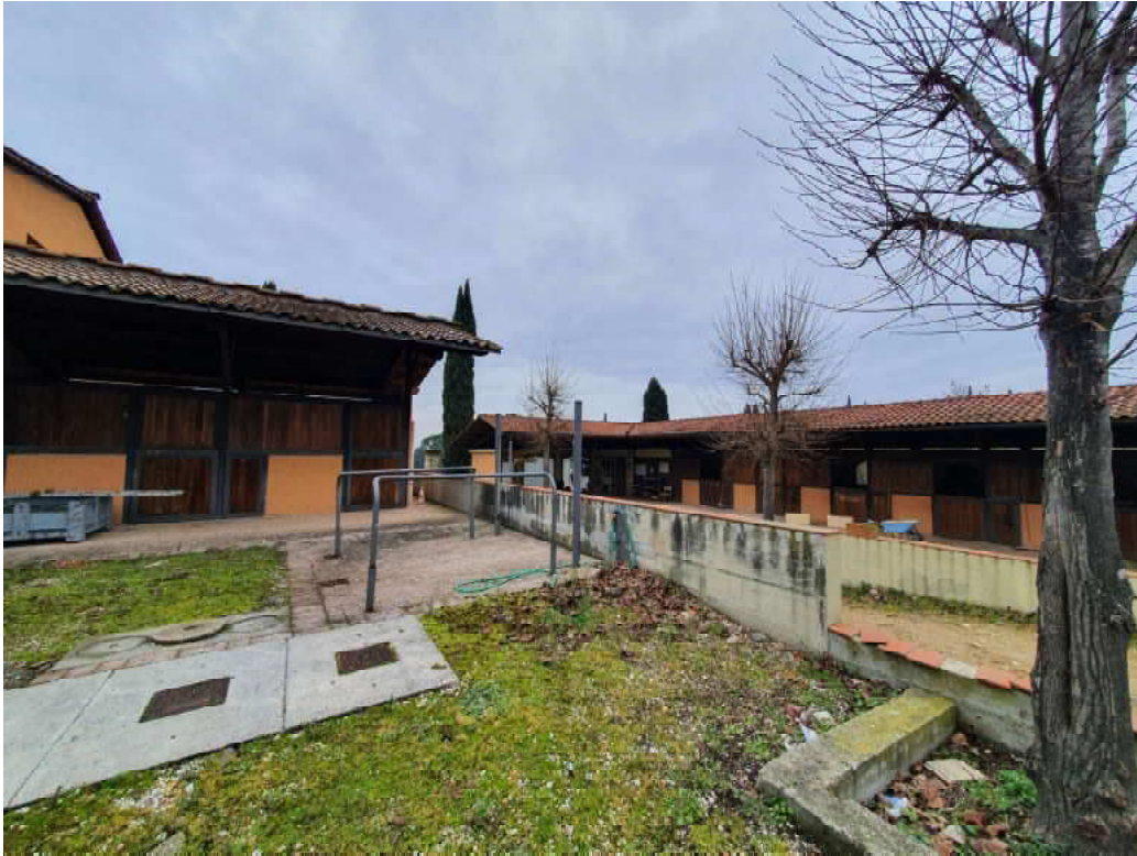
FOTO 19 – Ripresa fotografica vista verso stalle blocco A
