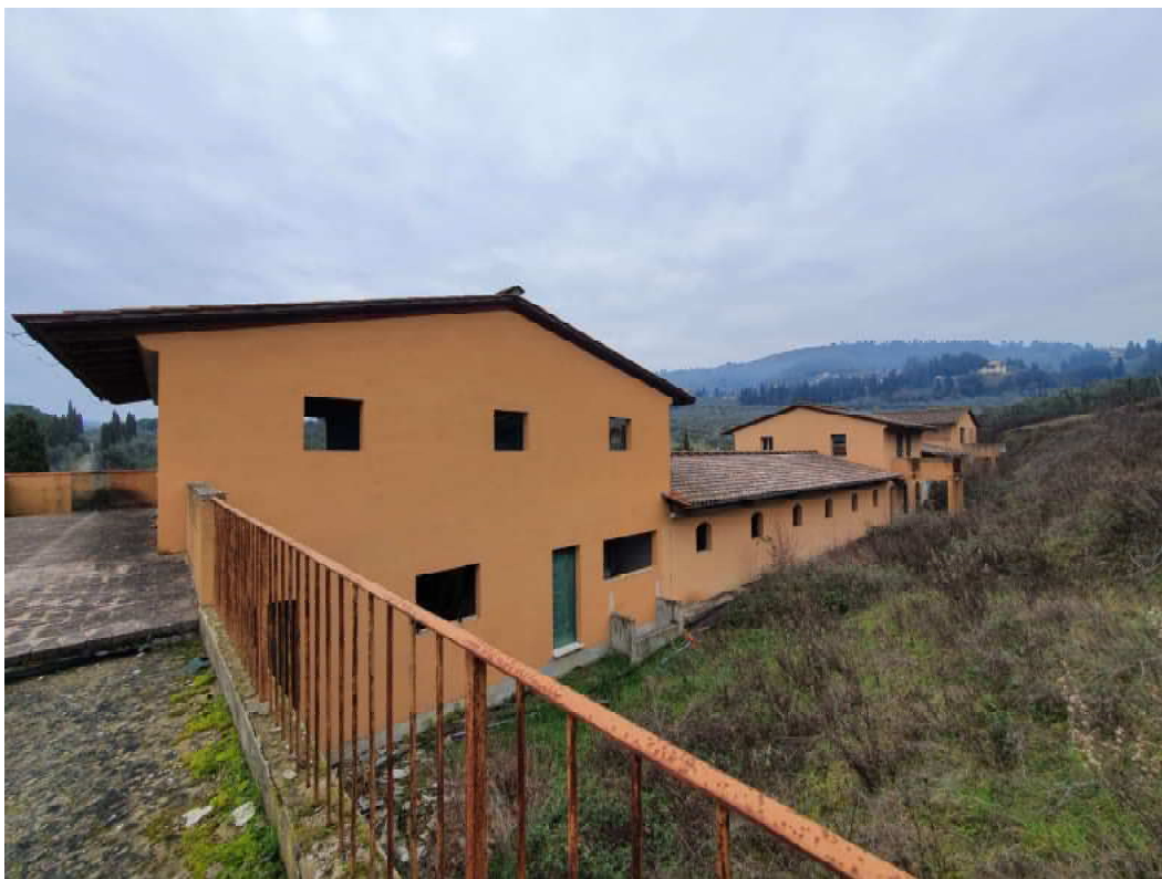
FOTO 04 – Ripresa fotografica blocco C maneggio/stalla
