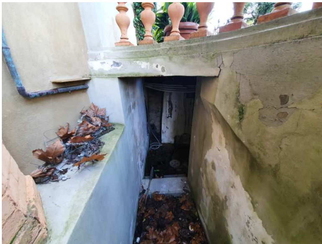
FOTO 22 – Ripresa fotografica dell'accesso ai vani tecnici interrati (non oggetto di esecuzione)
