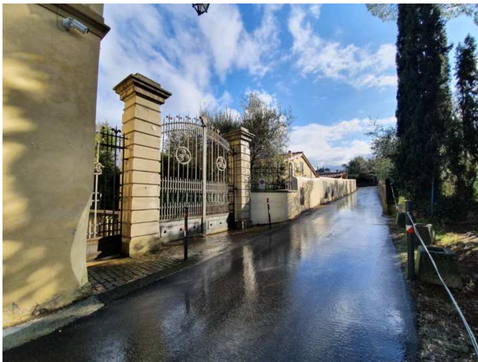
FOTO 01 – Cancelli di ingresso da via Vernalese
